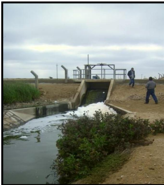
*Fotografía 7 Compuerta de salida de la PTAR San José*
