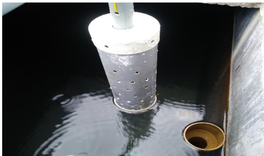
Fotografía 23: Puesta en funcionalidad del sistema de cloración por difusión
