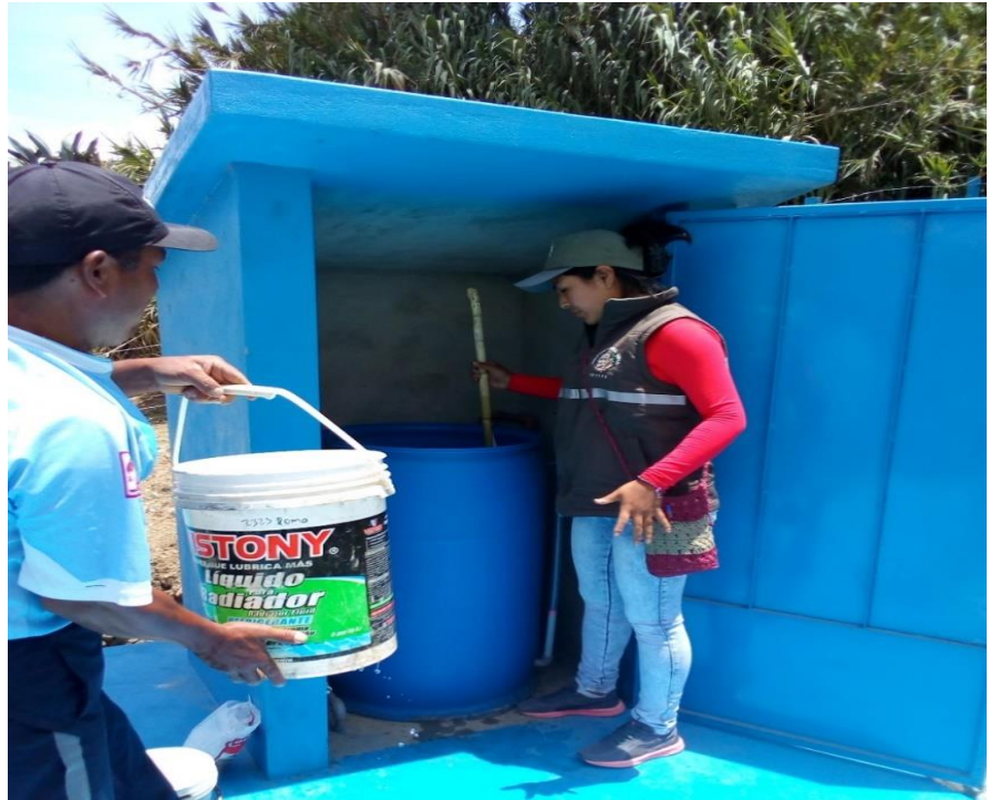
Fotografía 17: Recarga del hipoclorito de calcio cada 17 días en el tanque clorador
