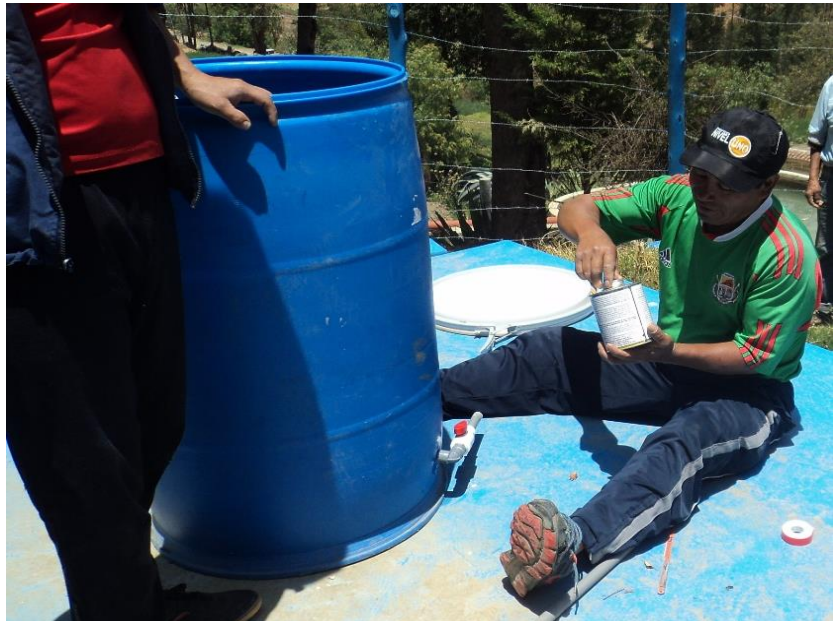
Fotografía 15: Reemplazo de la llave de paso y la manguerilla de salida
