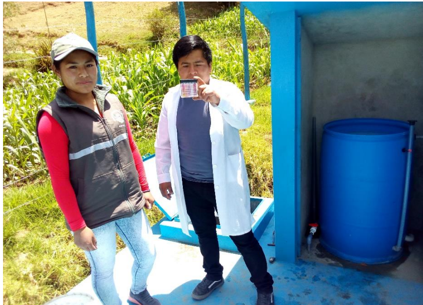
Fotografía 14: Prueba de funcionabilidad en sistema de cloración por goteo - negativo
