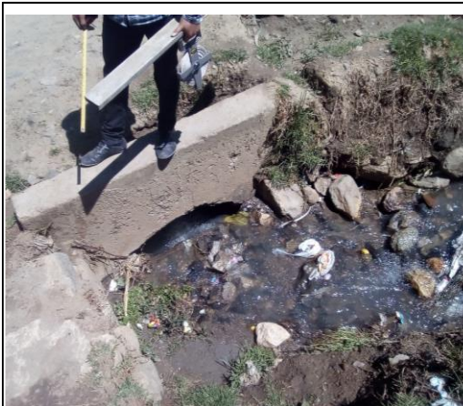
Foto 05: Alcantarilla de Concreto KM 00+865.2
