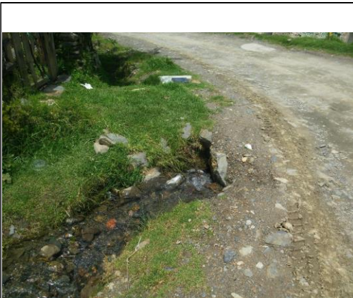
Foto 33: Alcantarilla de Piedra Km 05+650
