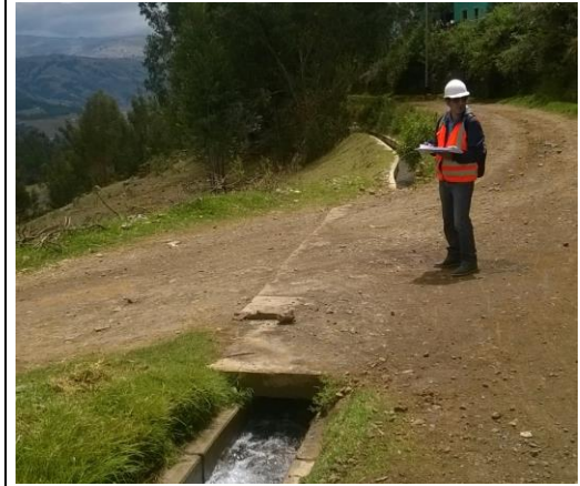
Foto 44: Alcantarilla de Concreto Km 07+134
