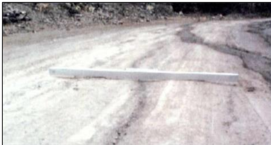
Figura 18. Erosión - Gravedad 1: Sensible al usuario, pero < 5 cm. Fuente: Manual de Carreteras de Mantenimiento, MTC-2014.
