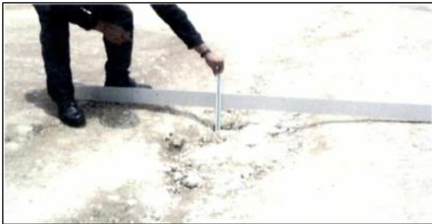
Figura 20. Erosión - Gravedad 3: Profundidad \geq 10 cm. Fuente: Manual de Carreteras de Mantenimiento MTC-2014.
