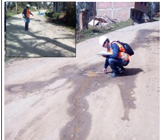
Foto 22: Carretera en malas Condiciones (Daños por Baches)
