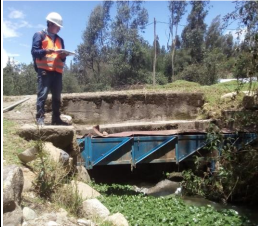
Foto 13: Alcantarilla de Concreto KM 02+042
