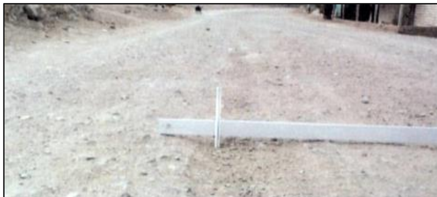
Figura 15. Deformación - Gravedad 1: Huellas / hundimientos sensibles al usuario, pero < 5 cm.
