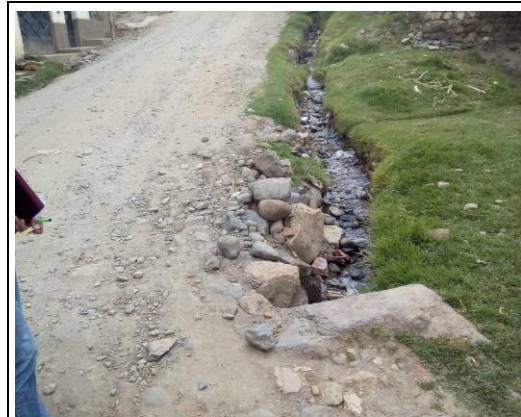
Foto 28: Alcantarilla de Piedra Km 04+521
