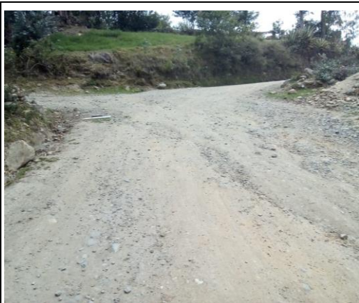
Foto 35: Desvio a AQUIA - Km 05+815
