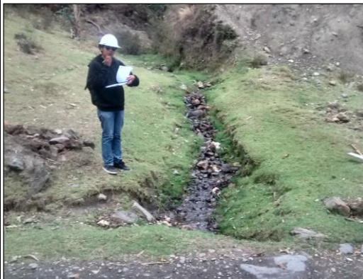
Foto 39: Alcantarilla de Piedra Km 06+674
