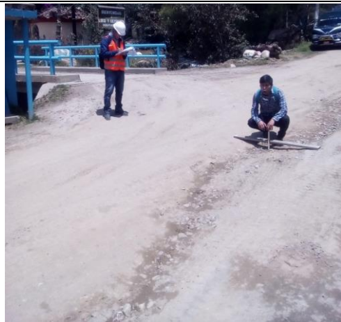
Foto 15: Desvio a Lirio y Ocopampa Km 02+383
