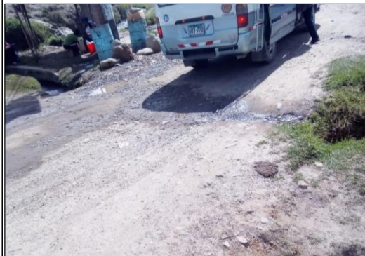
Foto 21: Alcantarilla de Mamposteria Km 03+174
