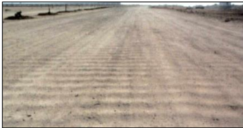
Figura 24. Encalaminado - Gravedad 1: Sensible al usuario, pero < 5cm.
