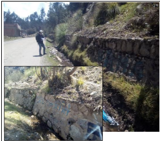
Foto 10: Muro de Mamposteria KM 01+532 - 01+650
