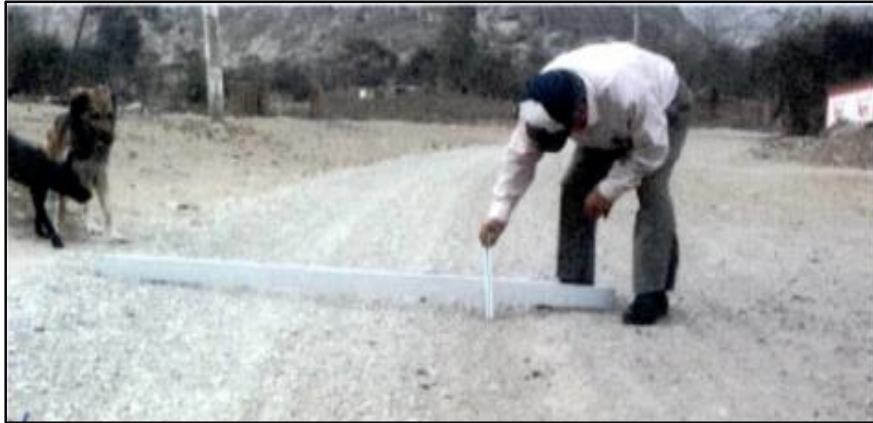
Figura 16. Deformación - Gravedad 2: Huellas/hundimientos entre 5 cm y 10 cm.
