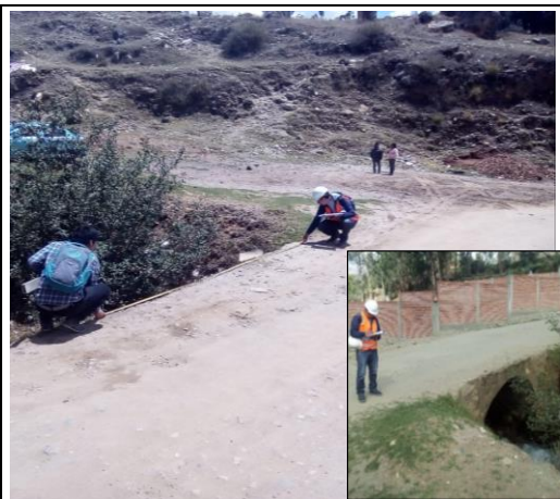
Foto 17: Ponton de Mamposteria KM 02+845
