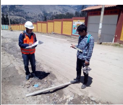
Foto 07: Carretera en malas Condiciones KM 01+250 (Daños por Erosion)
