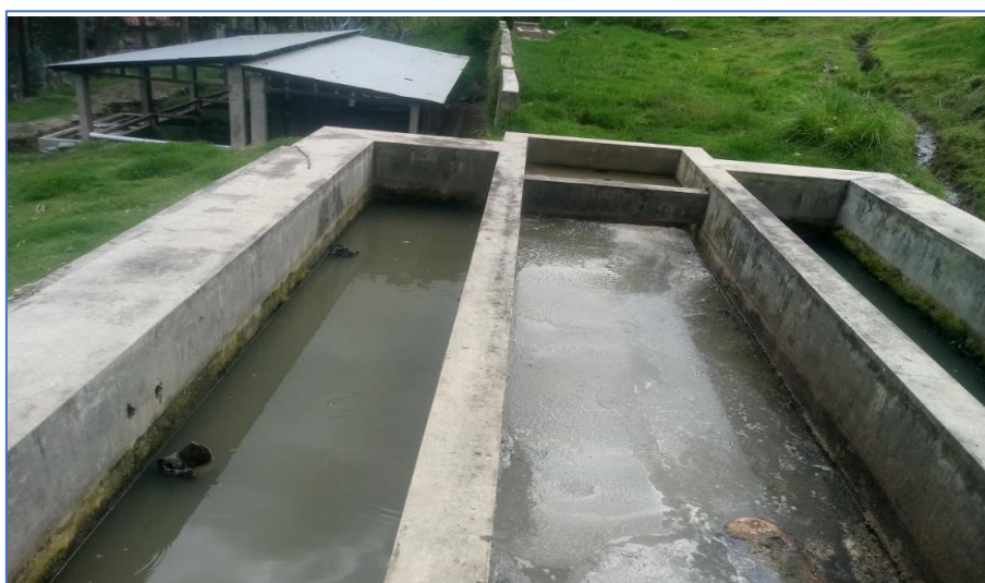
Figura 32. Vista de las condiciones actuales del Tanque Imhoff.
