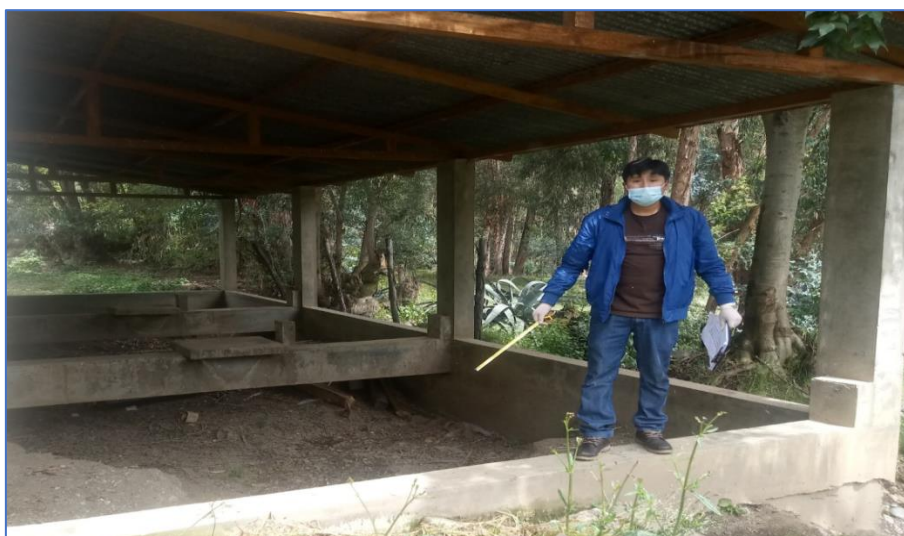
Figura 69. Vista interior del lecho de secado de la PTAR N° 03
