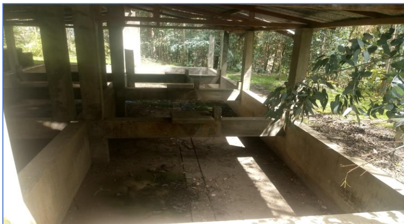
Figura 55. Vista interior del lecho de secado de la PTAR N° 02
