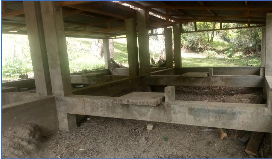
Figura 70. Vista interior del lecho de secado de la PTAR N° 03
