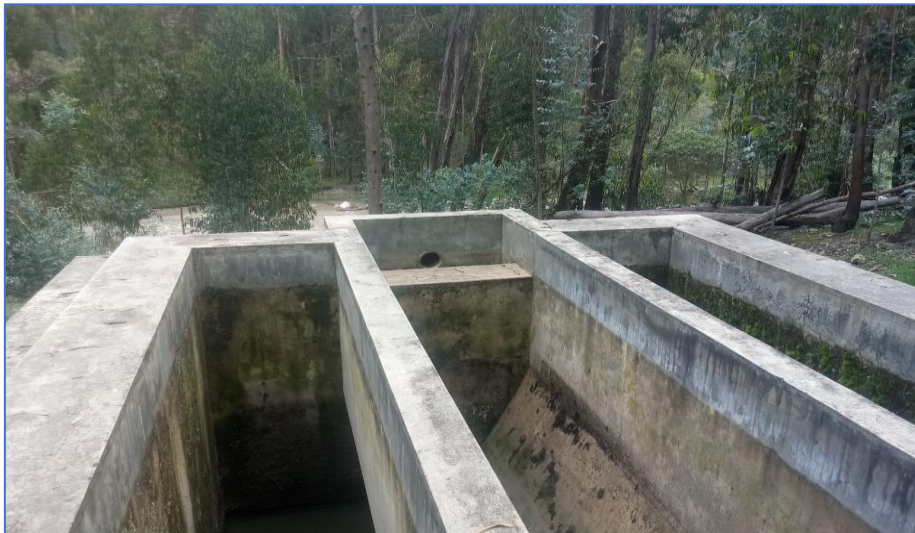
Figura 48. Vista de las condiciones actuales del Tanque Imhoff.
