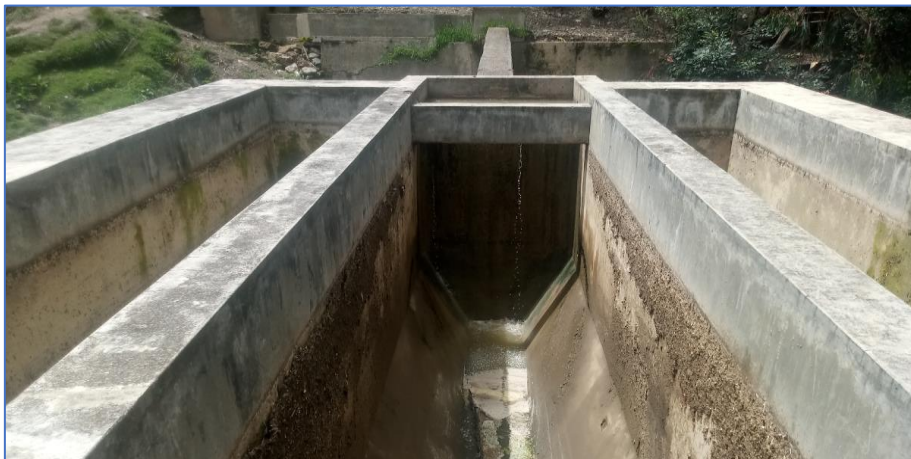
Figura 63. Vista de las condiciones actuales del Tanque Imhoff.
