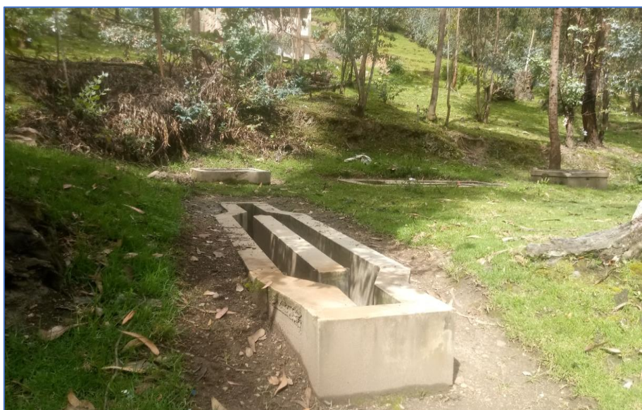
Figura 44. Vista general del desarenador y la cámara de rejillas
