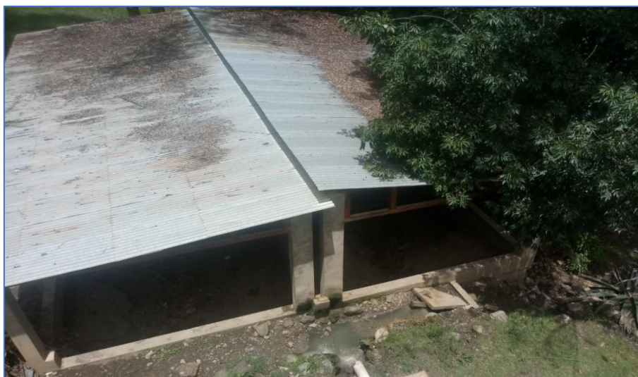
Figura 68. Vista general del Lecho de Secado de la PTAR N° 03
