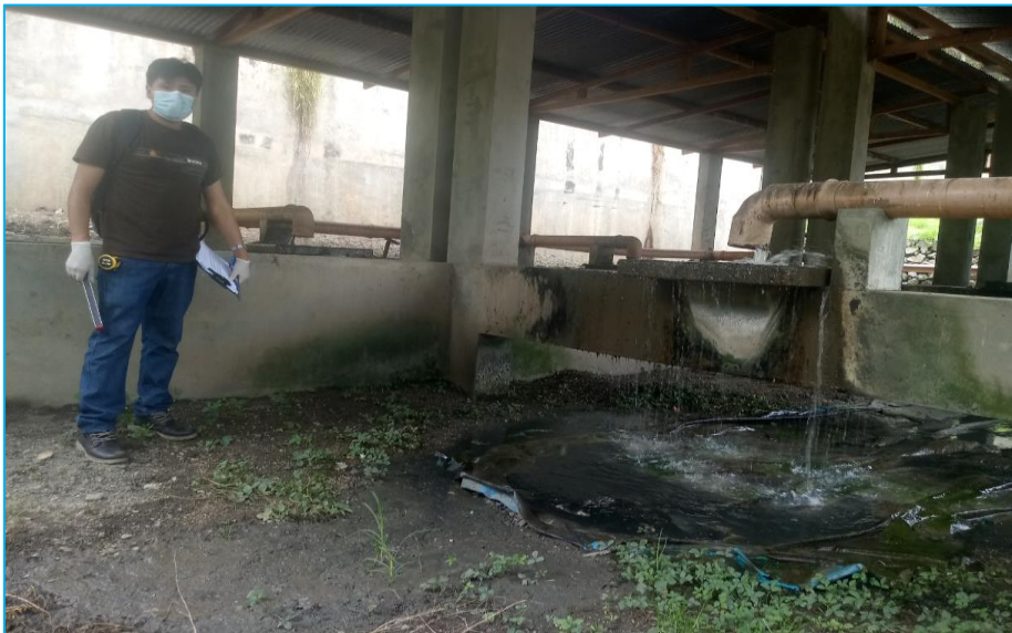
Figura 40. Vista interior del lecho de secado de la PTAR N° 01
