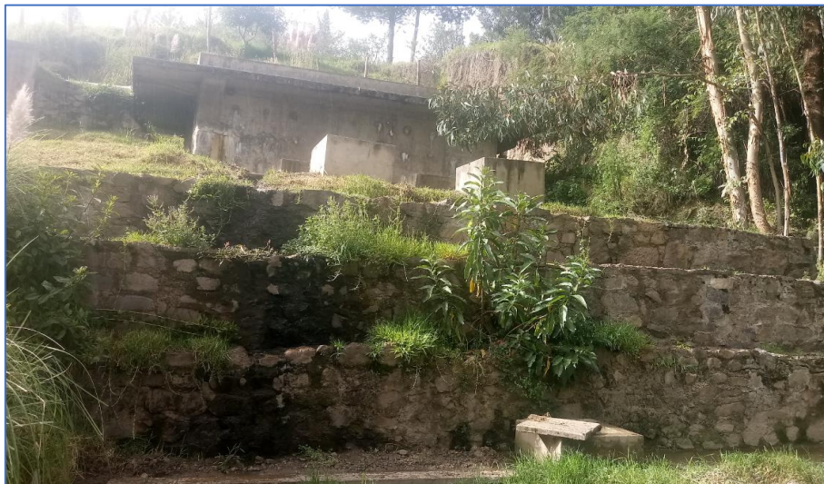
Figura 30. Vista del Tanque Imhoff
