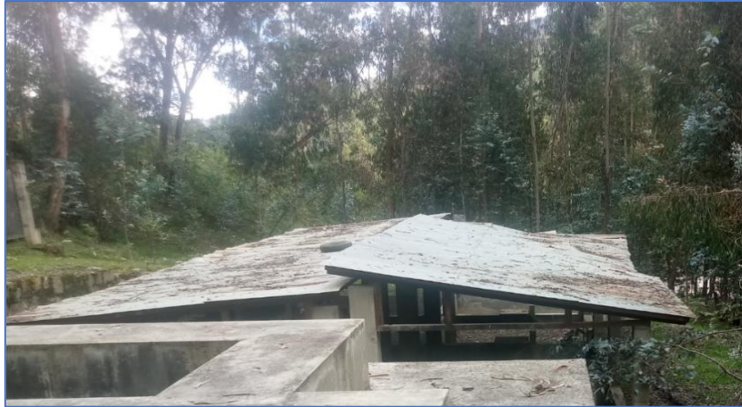
Figura 53. Vista general del Lecho de Secado de la PTAR N° 02
