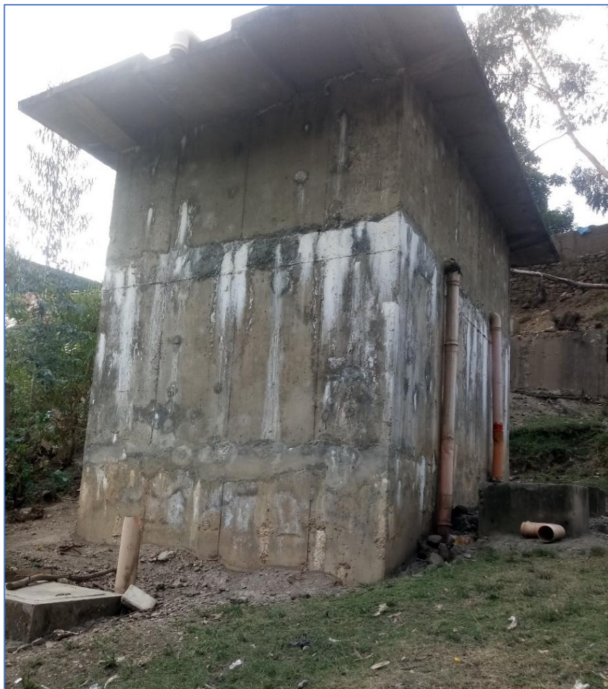
Figura 6. Tanque Imhoff de la PTAR N° 03
