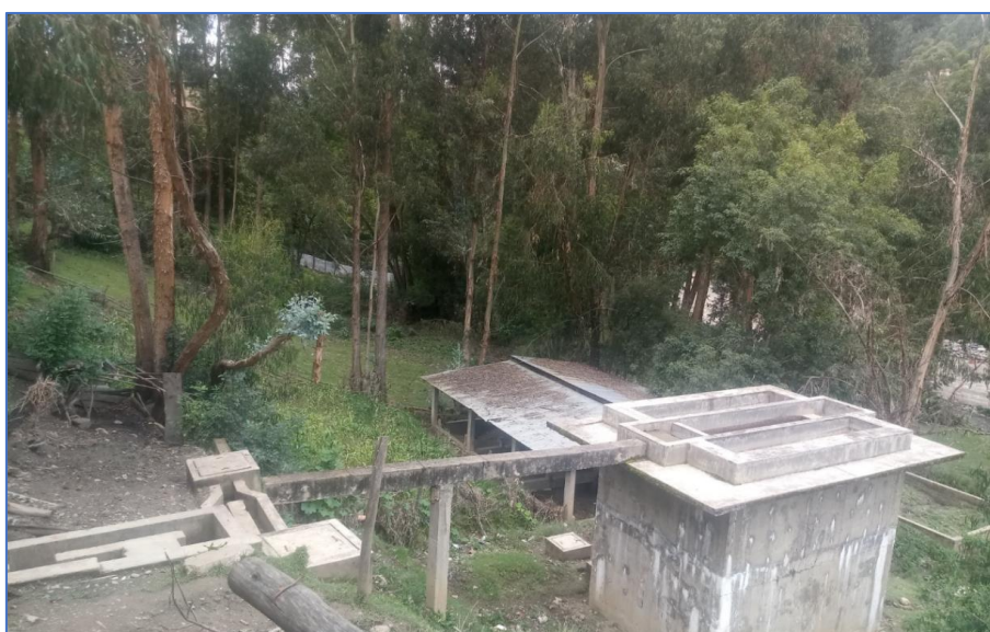
Figura 58. Vista panorámica de la PTAR N° 03
