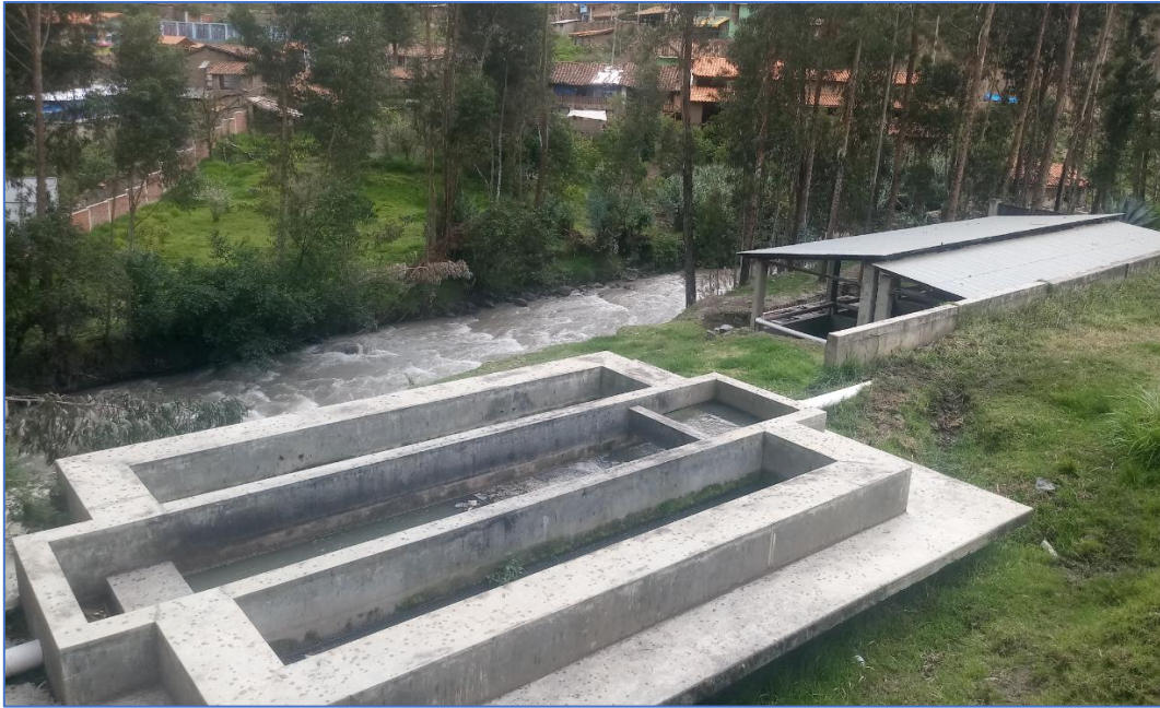
Figura 25. Vista panorámica de la PTAR N° 01
