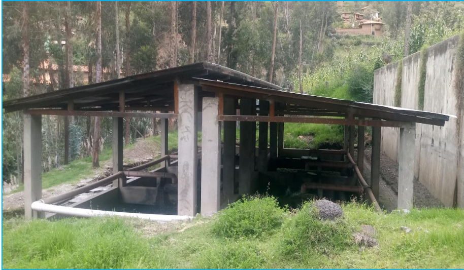
Figura 38. Vista general del Lecho de Secado de la PTAR N° 01
