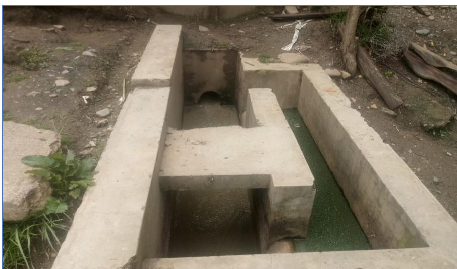
Figura 60. Vista de las condiciones actuales del desarenador.
