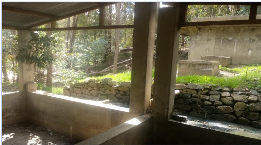
Figura 54. Vista interior del lecho de secado de la PTAR N° 02
