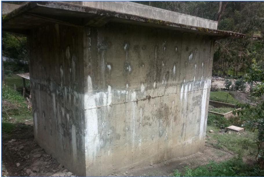
Figura 61. Vista del Tanque Imhoff
