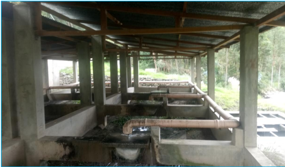
Figura 39. Vista interior del lecho de secado de la PTAR N° 01
