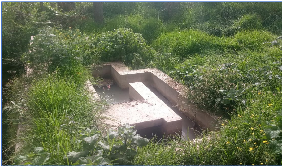
Figura 27. Vista de las condiciones actuales del desarenador.
