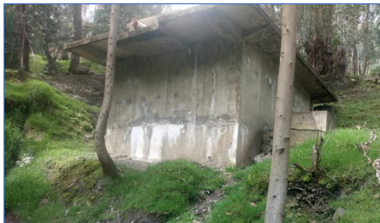
Figura 46. Vista del Tanque Imhoff
