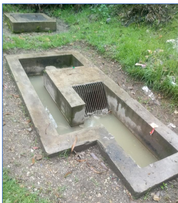
Figura 45. Vista de las condiciones actuales del desarenador
