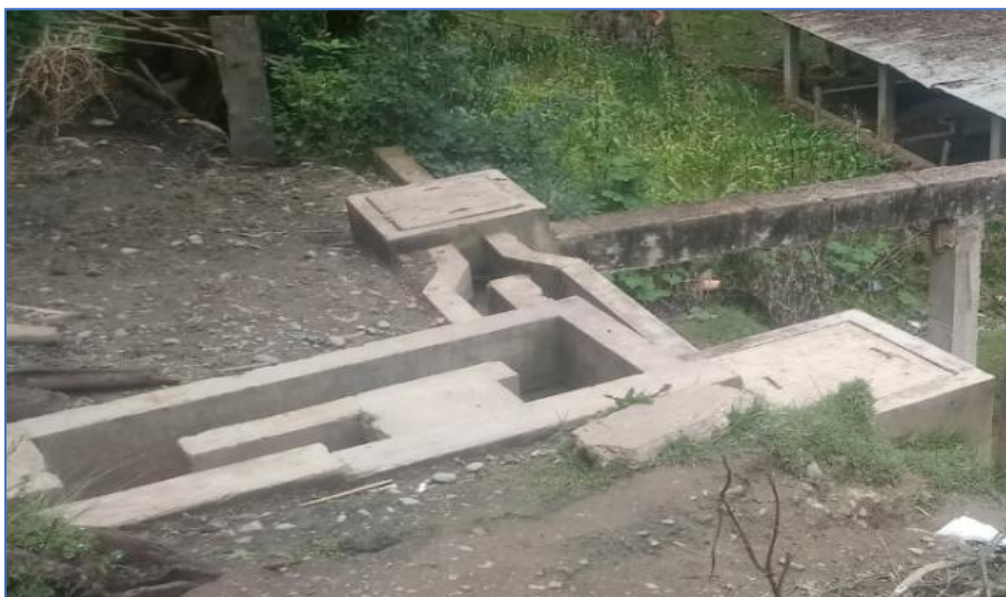
Figura 59. Vista general del desarenador y la cámara de rejillas
