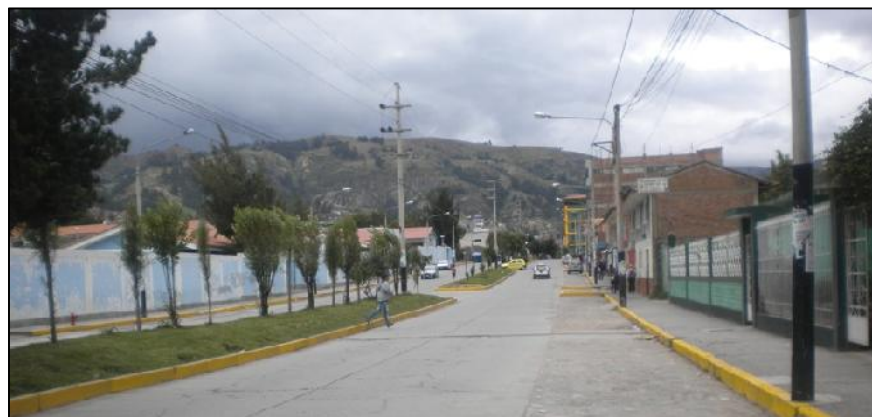
Fotografía N° 07: Línea de borde amarilla (señal horizontal longitudinal más frecuente en vías estudiadas)
