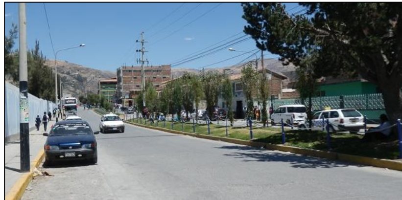
Fotografía N° 04: Estacionamiento prohibido que no afecta el tránsito (Av. Agustín Gamarra)
