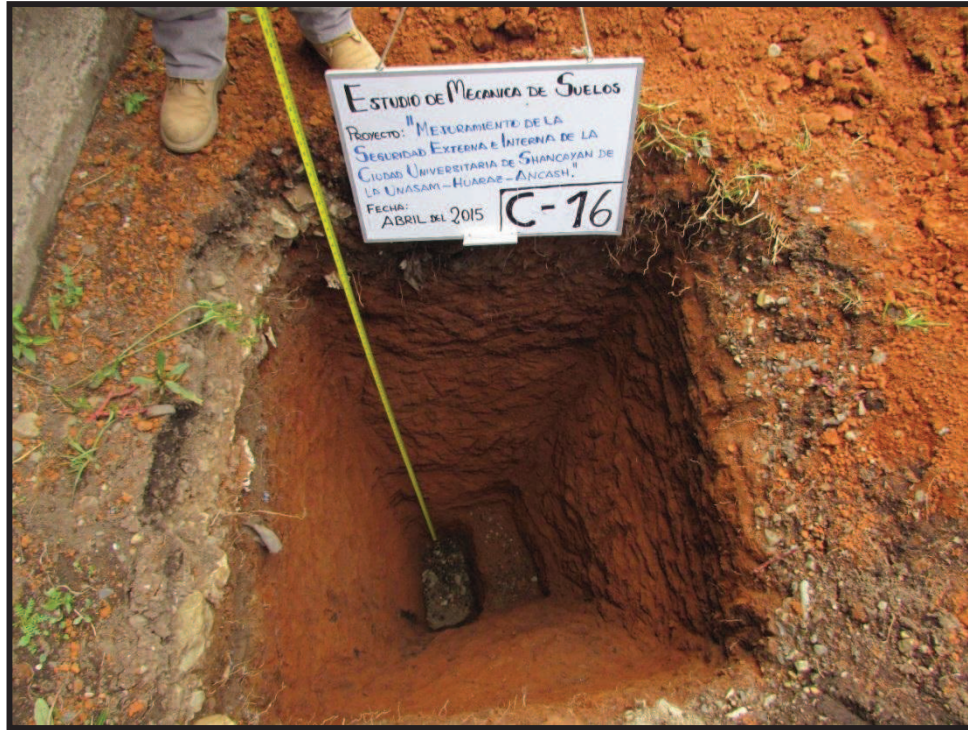
Figura 31: Se muestra la profundidad alcanzada y el tipo de suelo encontrado, se nota la presencia una arcilla de alta plasticidad.
