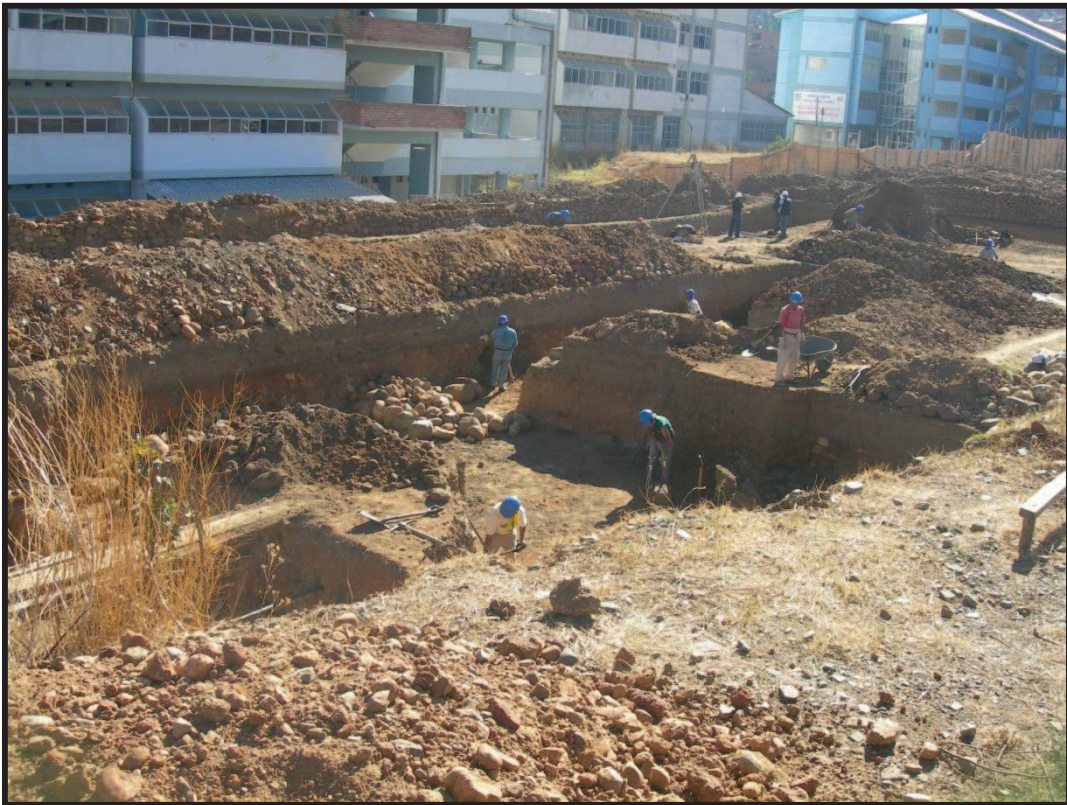
Figura 33: Se muestra la construcción de la facultad de ingeniería civil, donde se nota la presencia de gravas con la mezcla de arcillas, francos de arcilla y como arcillas con gravas.
