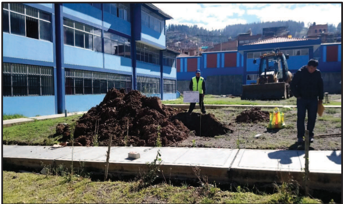
Figura 34: Se muestra la calicata N° 02, excavada con la ayuda de una retroexcavadora para poder llegar a profundidades mayores a 3 m.
