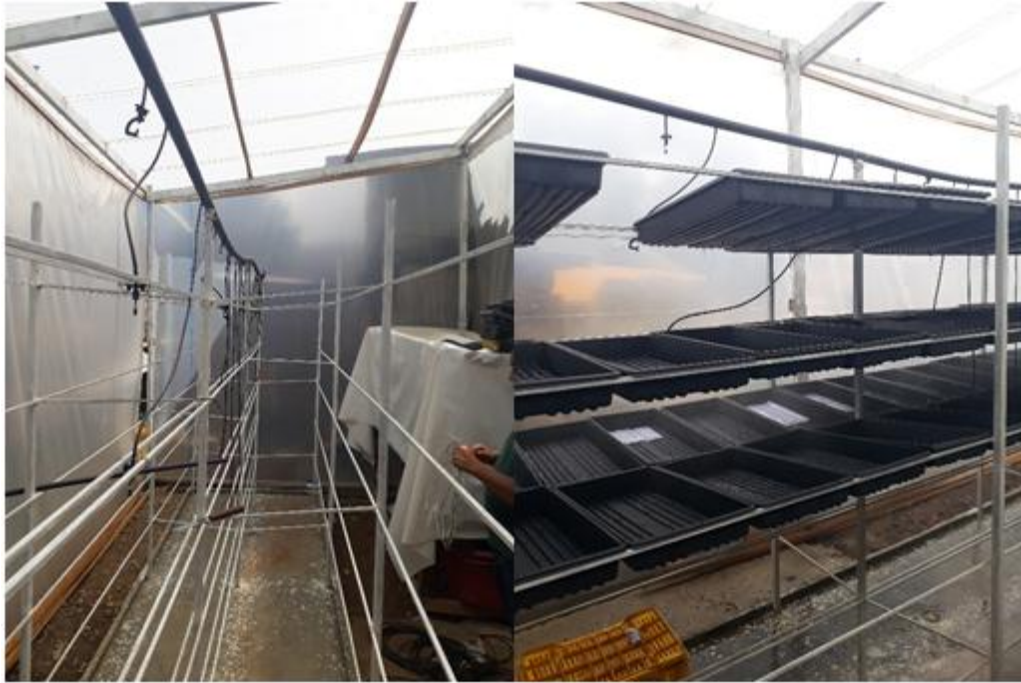
Fotografías N°01: Instalación del sistema de microriego y de las bandejas para el sembrado
