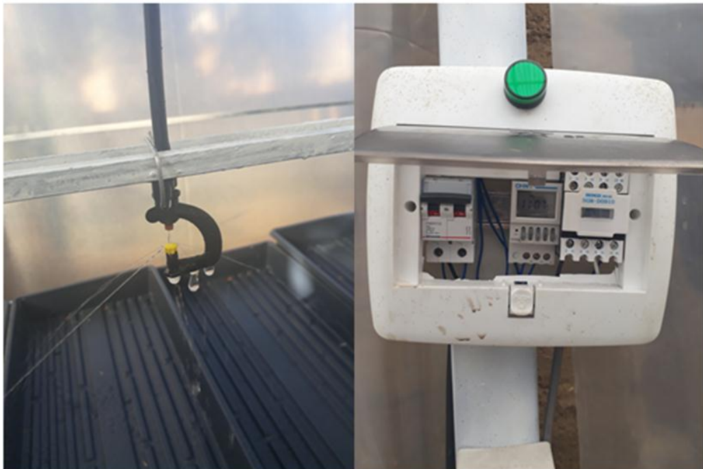
Fotografías N°02: Pruebas de campo con el programador de riego
