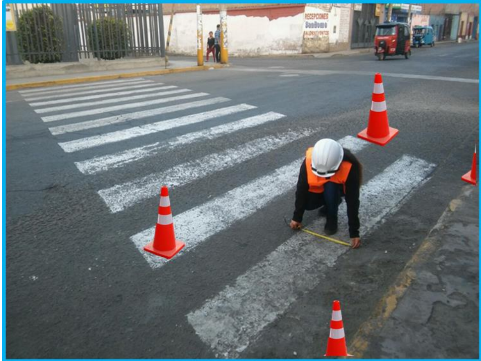
Fotografía N° 11: Medición de las marcas en el pavimento (ancho) para corroborar si cuentan con las medidas propuestas en el de MDCTACC.
