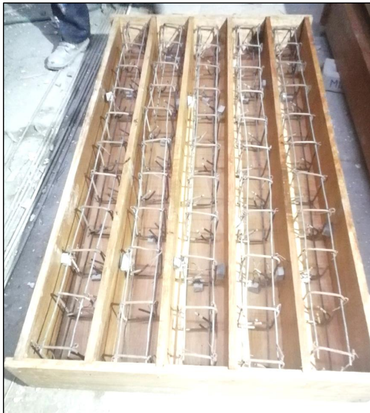
Figura N° 42. Molde de madera (encofrado) con el refuerzo ya colocado.
