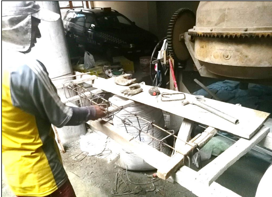
Figura N° 25. Armado del acero de refuerzo
