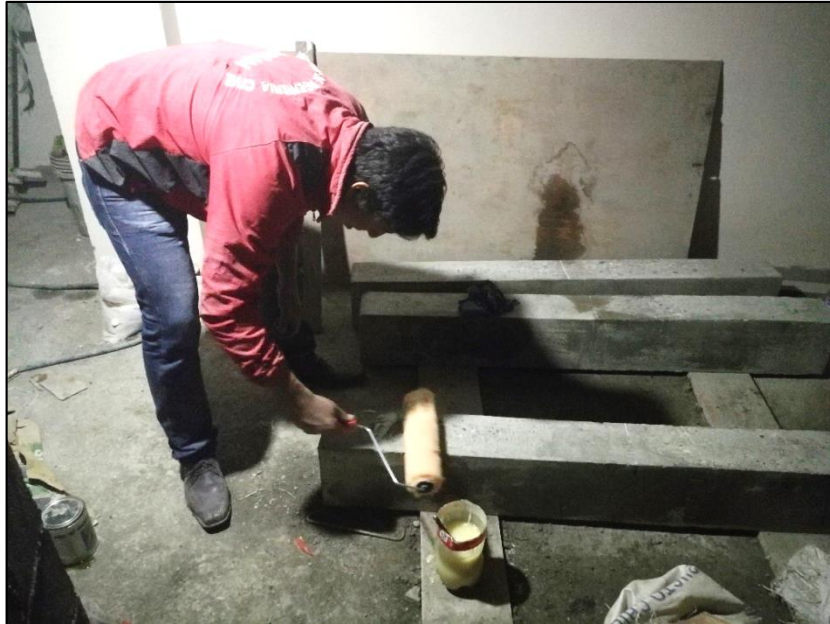
Figura N° 54. Colocado del pegamento epóxico proporcionado por el fabricante
