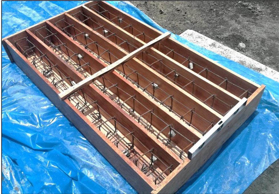
Figura N° 44. Colocado de los encofrados sobre la arena
