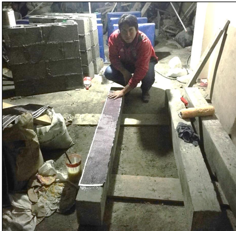
Figura N° 55. Colocado del refuerzo CFRP
