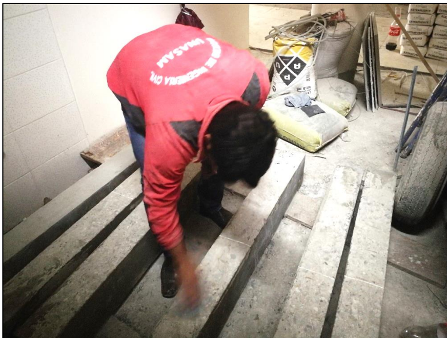
Figura N° 53. Ejecución del tratamiento de la superficie de unión
