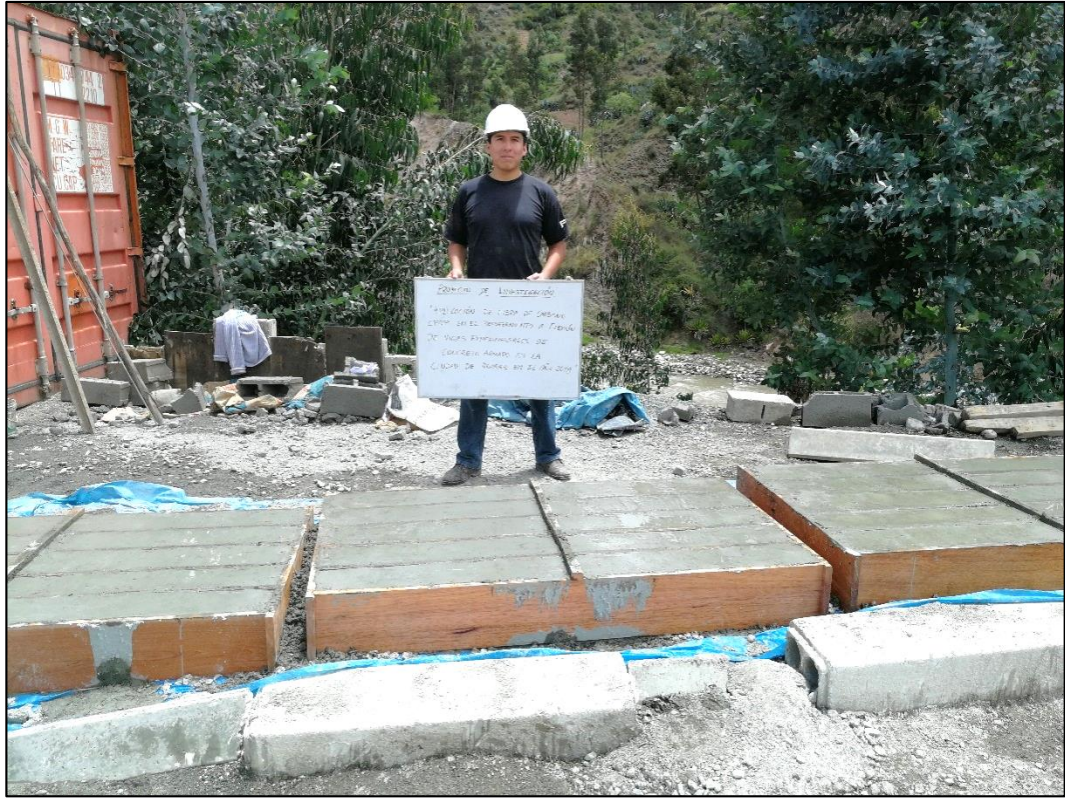
Figura N° 46. Vaciado y acabado de las vigas objetos de estudio
