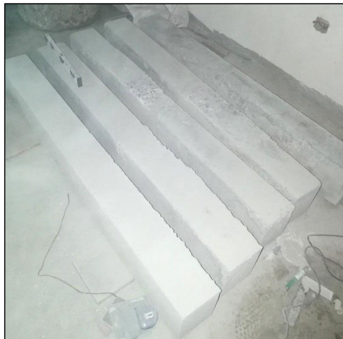
Figura N° 51. Desencofrado de vigas
