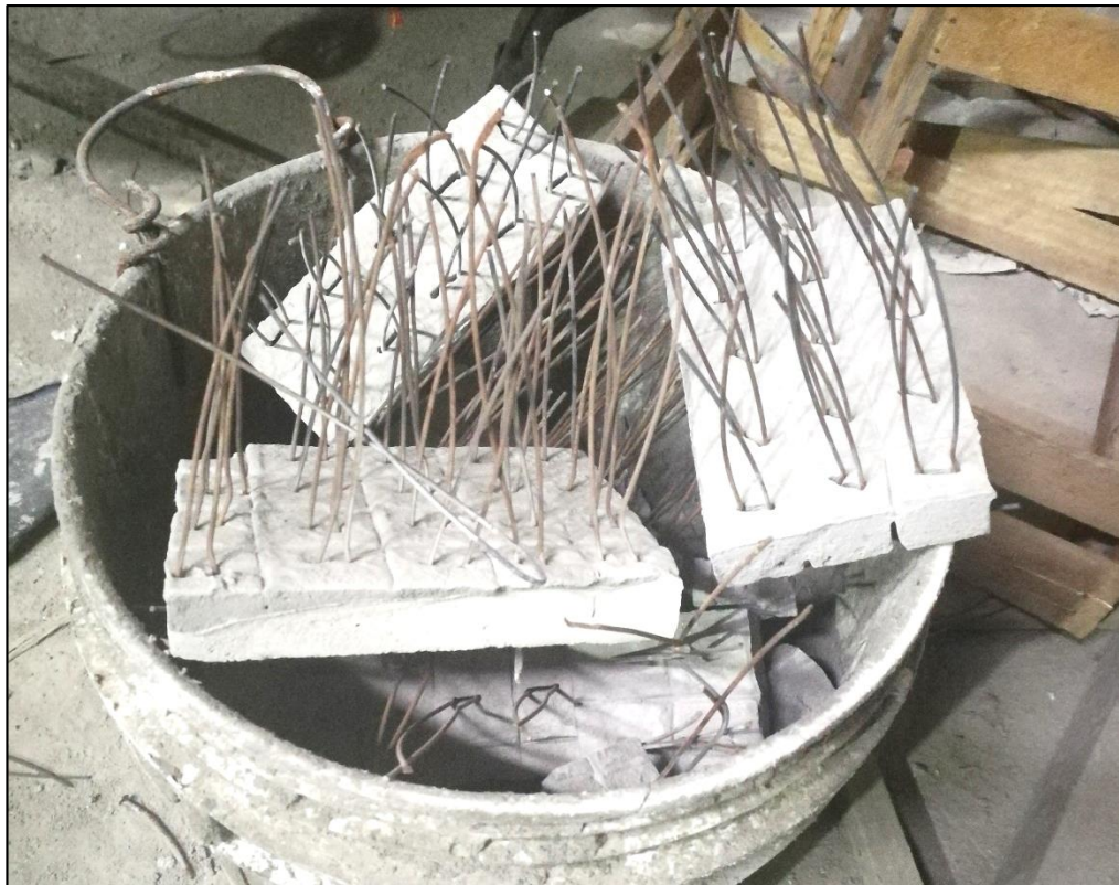
Figura N° 40. Dados de mortero para asegurar el recubrimiento
