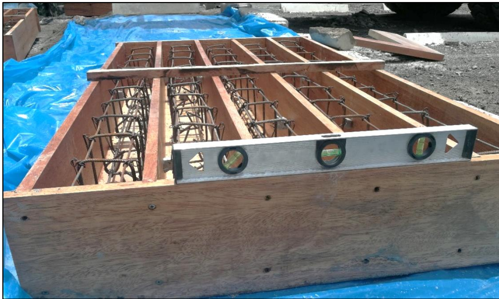
Figura N° 45. Nivelado de los encofrados
