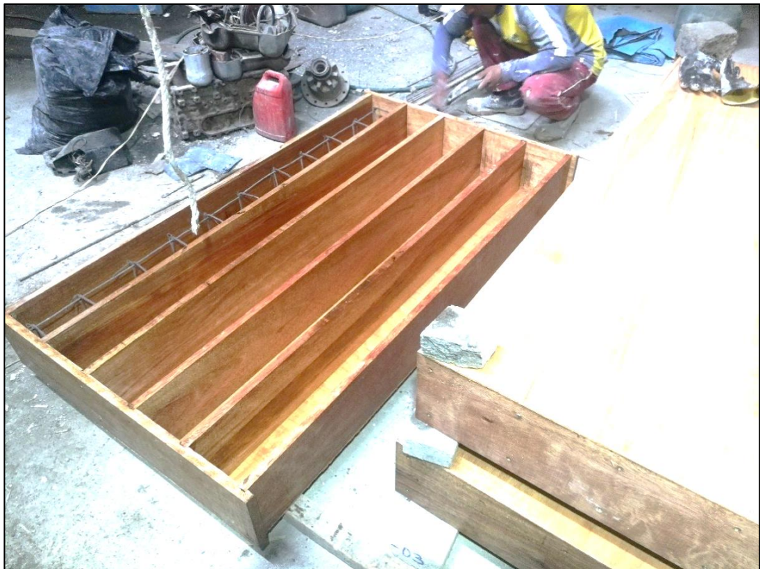
Figura N° 38. Colocado del refuerzo en los encofrados
