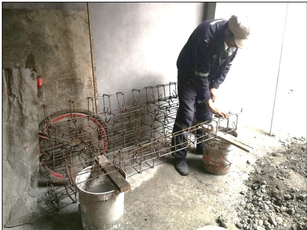
Figura N° 37. Armado del acero de refuerzo interior
