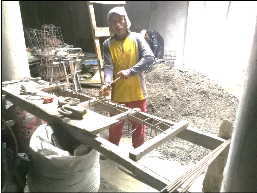
Figura N° 36. Habilitado del acero de refuerzo interior
