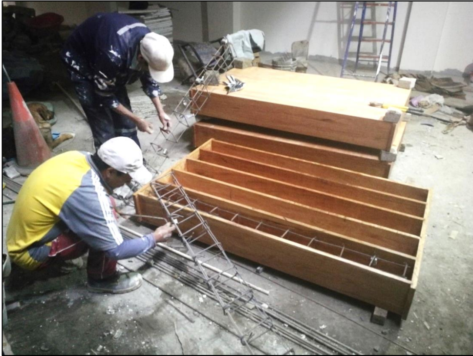
Figura N° 41. Colocado de dados en el acero de refuerzo
