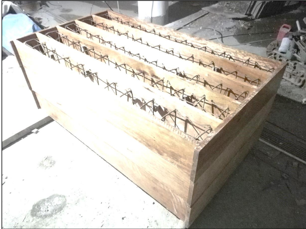
Figura N° 43. Moldes de 5 vigas cada uno preparados para el vaciado del concreto
