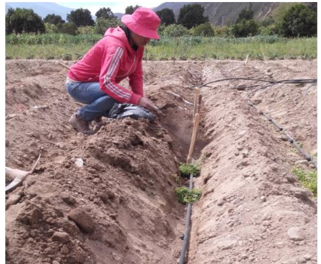
instalación de los laterales a 25 cm
