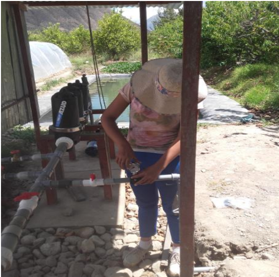
instalación del cabezal de riego
