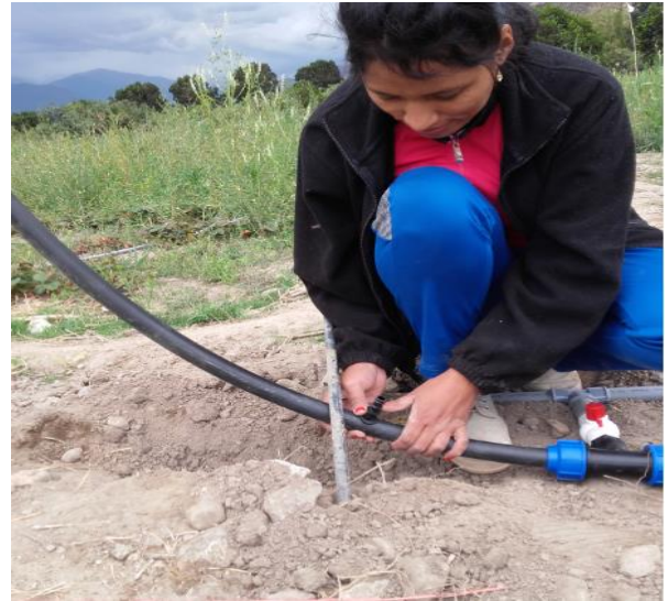
instalación de accesorios a las parcelas
