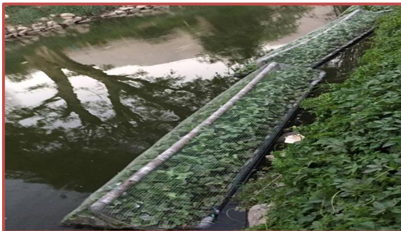
Figura 14: Sistemas flotantes implementados en el área de estudio.
