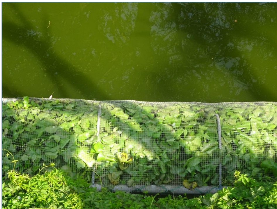
Fotografía N° 35: instalación de los sistemas flotantes mejorados; estos fueron colocados en todo el contorno (bordes) de la Laguna.
