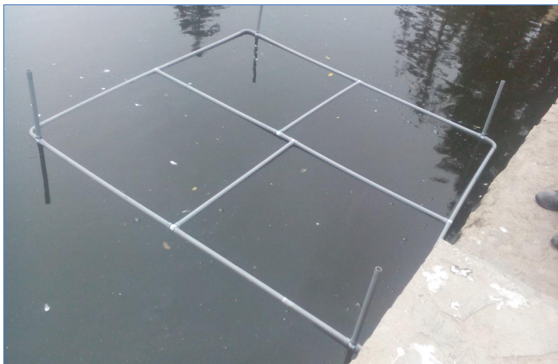
Fotografía N° 21: instalación de la primera alternativa de los sistemas flotantes, los cuales contendrán al Jacinto de agua. Fueron construidos mediante tuberías de PVC.
