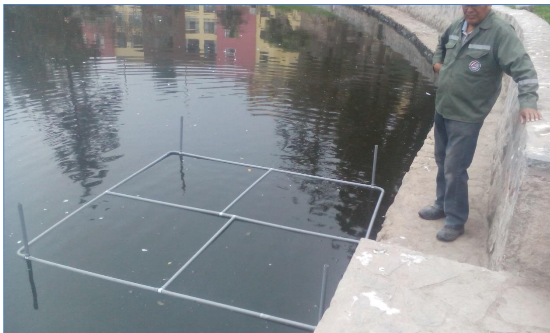
Fotografía N° 20: instalación de la primera alternativa de los sistemas flotantes, los cuales contendrán al Jacinto de agua. Fueron construidos mediante tuberías de PVC.
