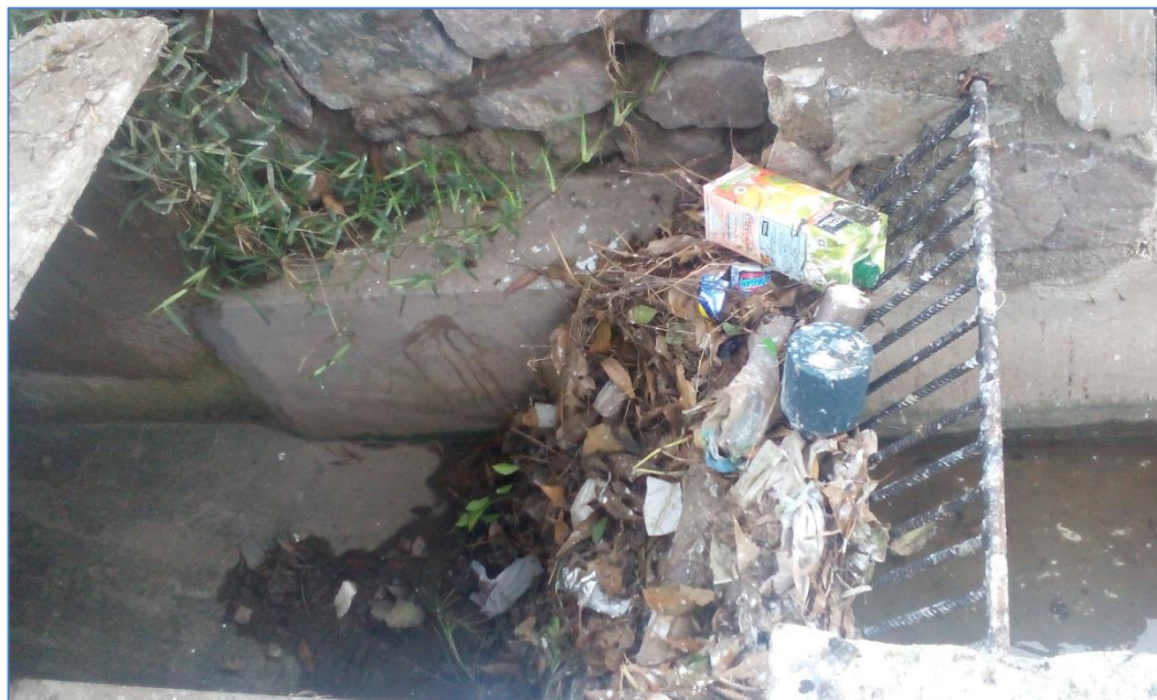
Fotografía N° 07: vista fotográfica de la cámara de rejas (único pre tratamiento con el que cuenta la laguna), se observa la separación de los sólidos de mayor tamaño.
