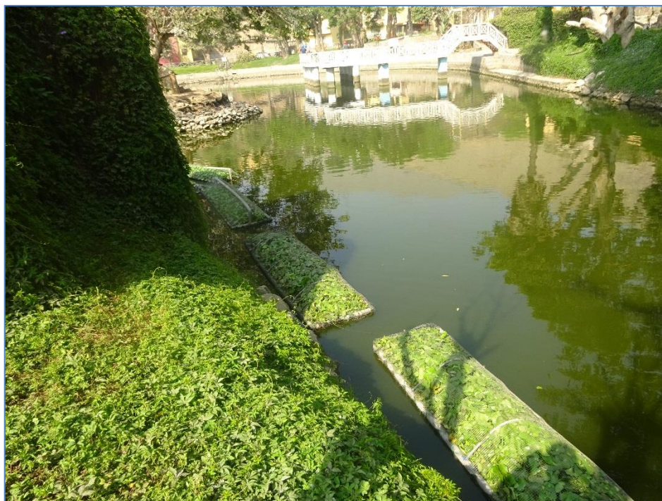
Fotografía N° 34: instalación de los sistemas flotantes mejorados; estos ya contienen una malla que protege a las plantas de ser consumidos por los animales como las aves y otros.
