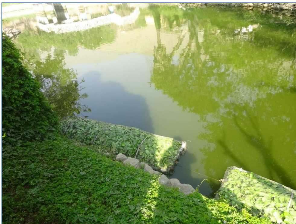
Fotografía N° 36: instalación de los sistemas flotantes mejorados; estos fueron colocados en todo el contorno (bordes) de la Laguna.
