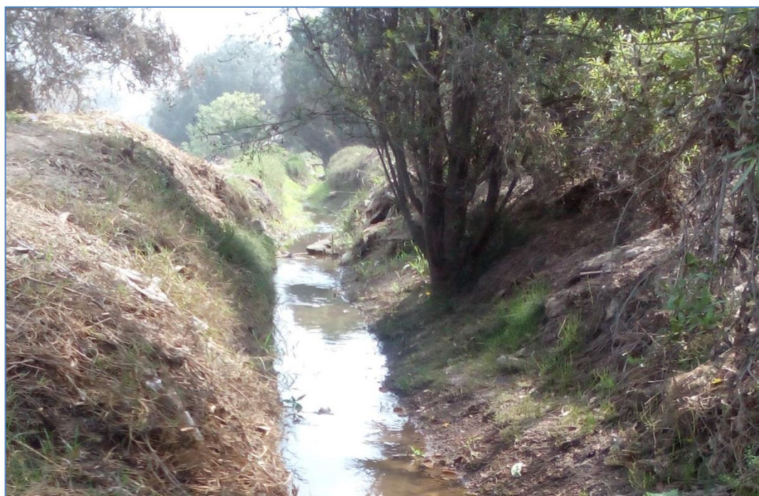
Fotografía N° 02: parte del canal por donde recorre las aguas residuales, las cuales llegan a la Laguna “La Mansión”.
