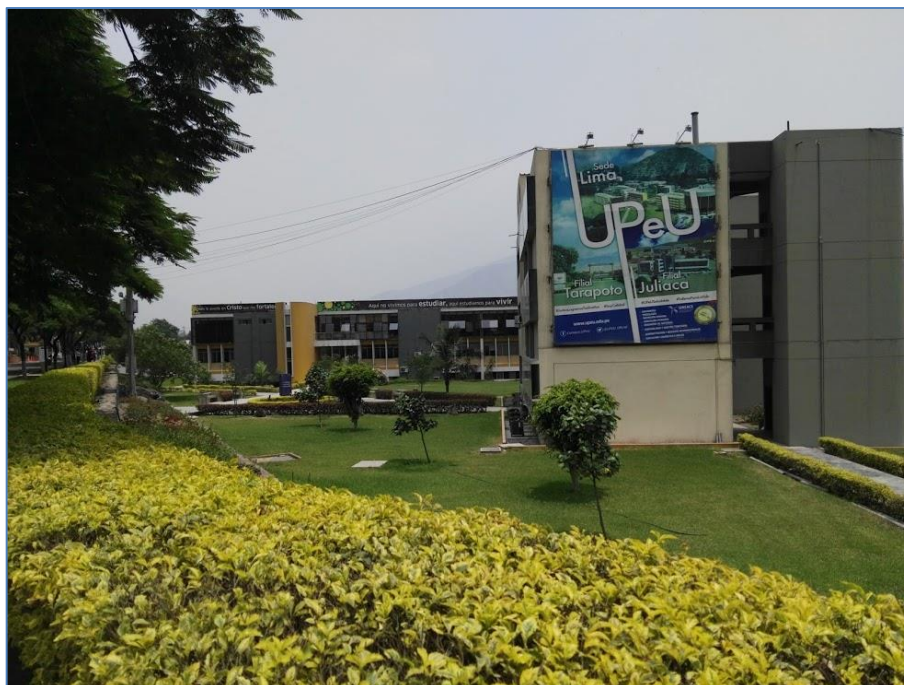
Fotografía N° 46: riego de áreas verdes utilizando el agua proveniente de la laguna, después de haber comprobado que el Jacinto de agua es eficaz en el tratamiento de las AA.RR.
