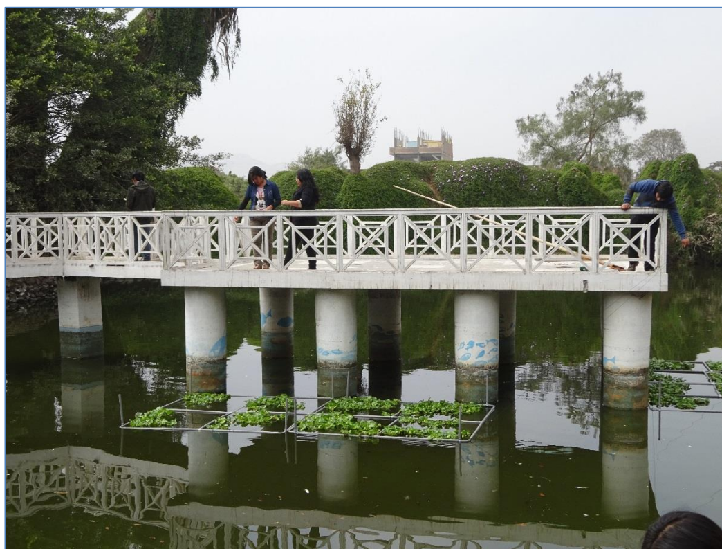
Fotografía N° 30: instalación de los sistemas flotantes en la Laguna “La Mansión”.
