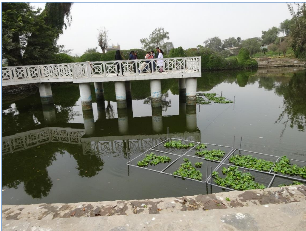
Fotografía N° 29: instalación de los sistemas flotantes en la Laguna “La Mansión”.
