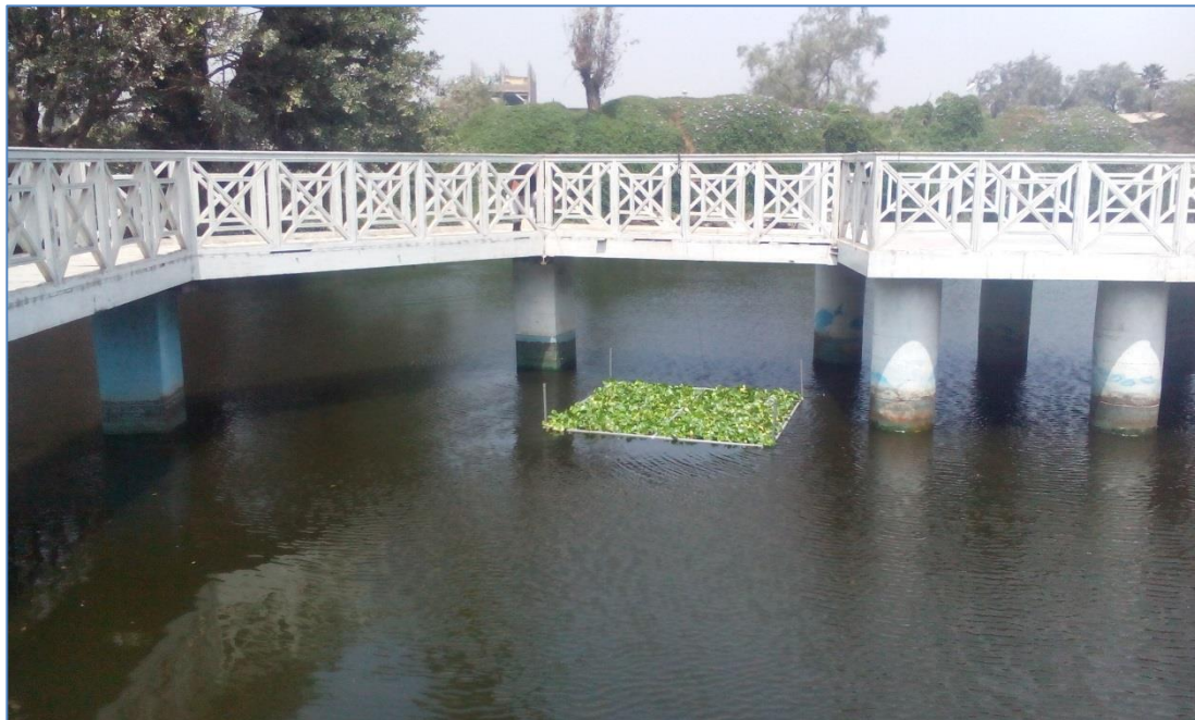
Fotografía N° 27: colocación del Jacinto de agua en el sistema flotante.
