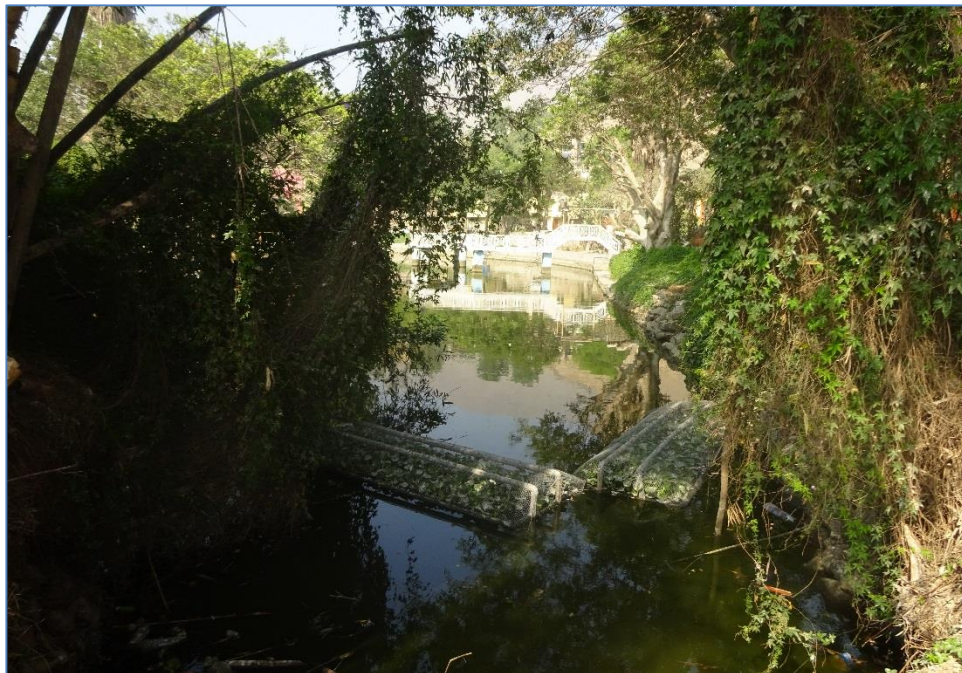
Fotografía N° 39: instalación de los sistemas flotantes mejorados; estos fueron colocados en todo el contorno (bordes) de la Laguna.
