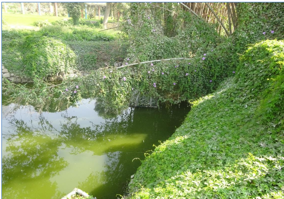
Fotografía N° 37: instalación de los sistemas flotantes mejorados; estos fueron colocados en todo el contorno (bordes) de la Laguna.
