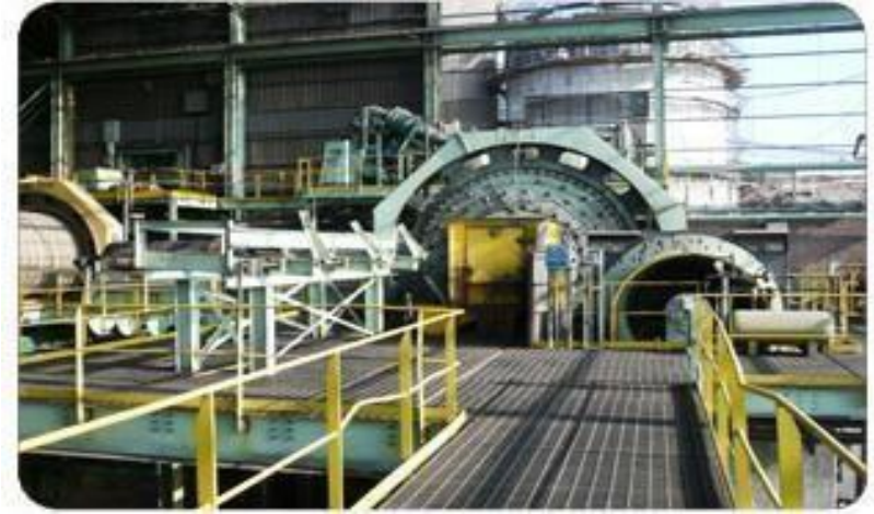
Fuente: Shougang FOTO N° 21. ZONA DE CONCENTRACIÓN
