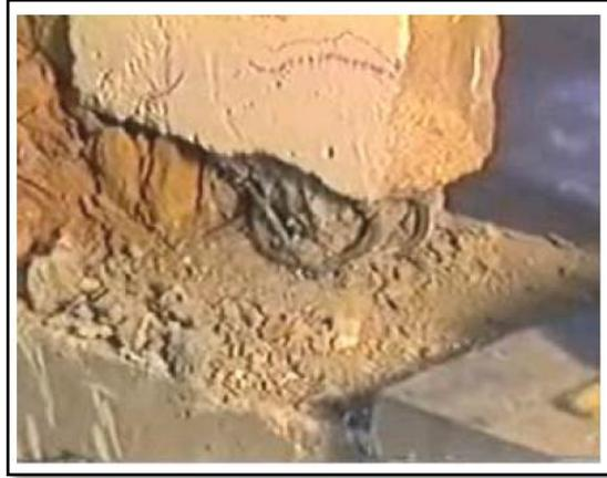
Figura 2.22 Talón triturado de un muro confinado
