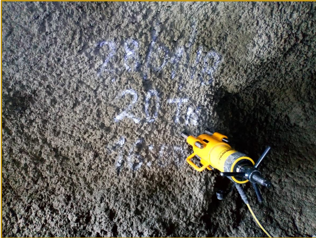
IMAGEN N°4-28 , Prueba de tracción en el túnel N°01 donde se registró 20 Tn de capacidad de carga.
