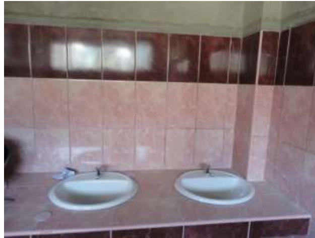
Foto N°14: Instalación de lavatorio (ovalines) en SSHH.
