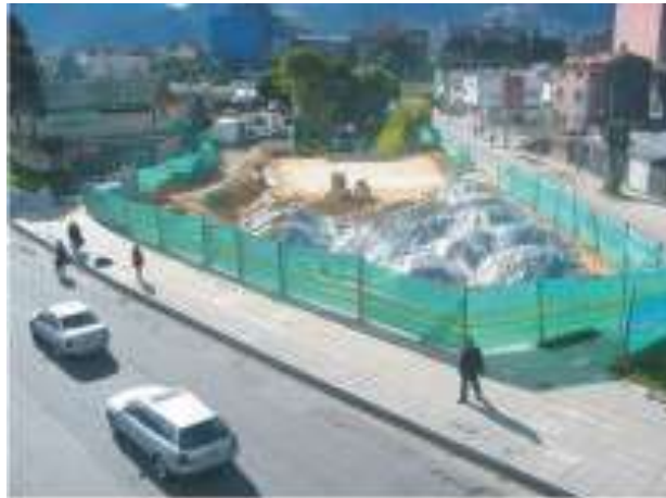
Figura N°55: Escombros bien protegidos antes de ser eliminados
