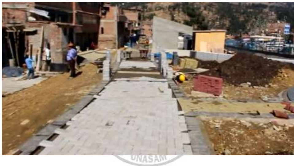
Foto N°12: Colocado de adoquines (superior e inferior)
