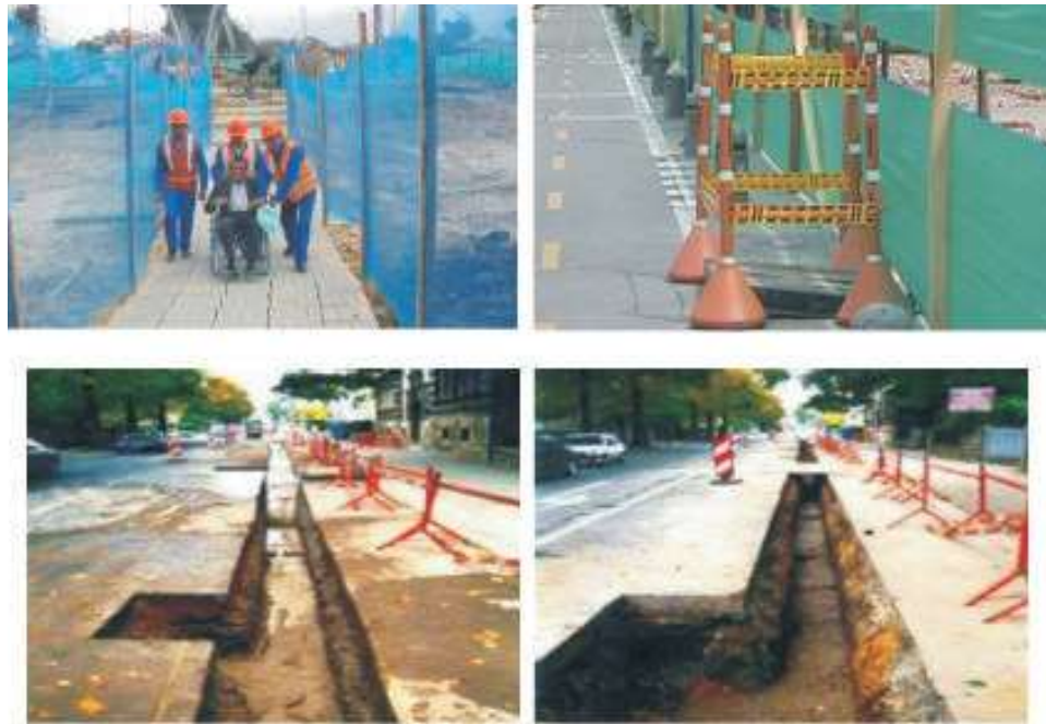
Figura N°50: Área de excavación debidamente señalizada.
