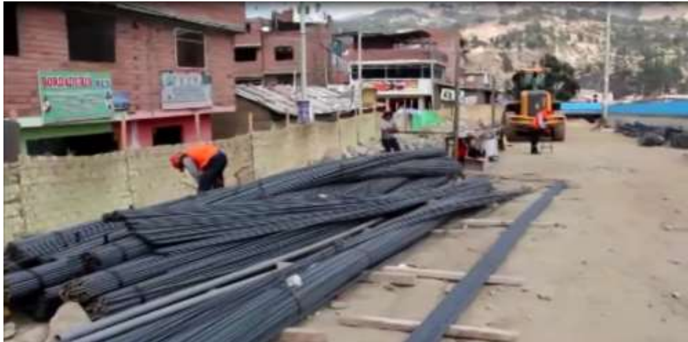
Foto N°03: Habilitado de fierros para el muro de contención.
