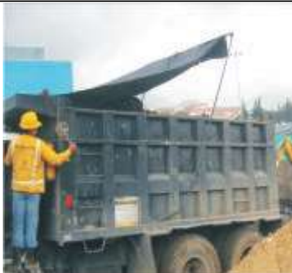
Figura N°53: Volquetes debidamente cubiertos con lona o plástico
