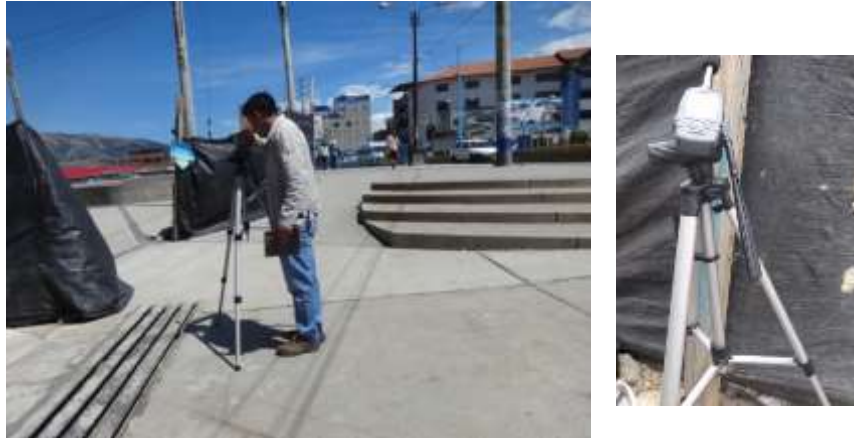
Figura N°24: Realizando la verificación del nivel de ruido en obra
