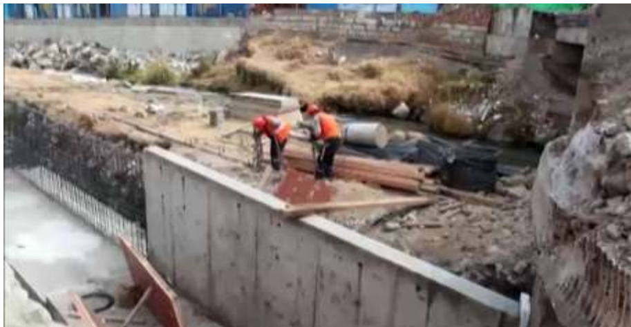
Foto N°07: Desencofrado de muros de muros de contención
