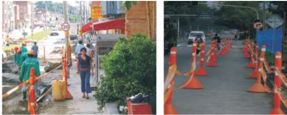
Figura N° 47: Dispositivos para canalización del tránsito debidamente colocados.
