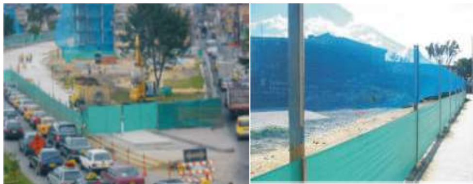
Figura N° 48: Perímetro de la obra delimitado completamente.
