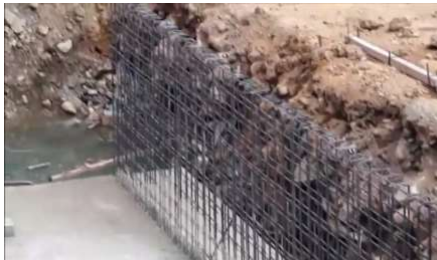
Foto N°04: Enmallado con acero corrugado
