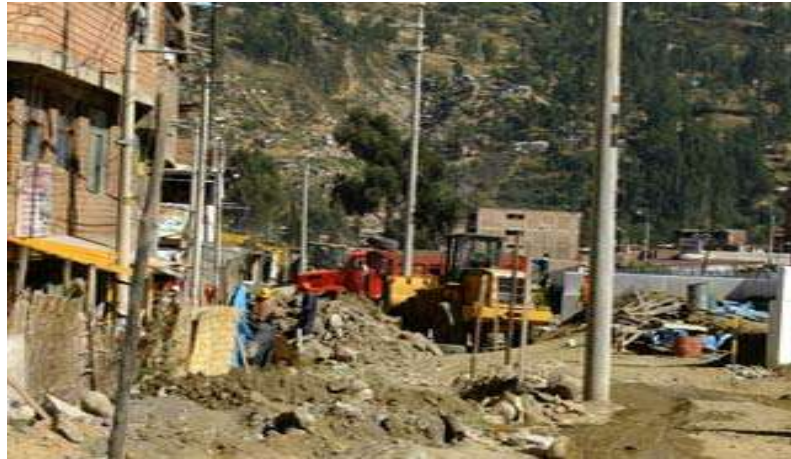
Foto N°09: Carguío para eliminación de desmontes.
