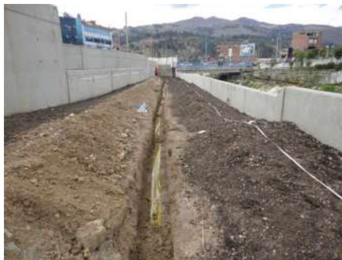
Foto N°11: Tendido de cable para el sistema eléctrico
