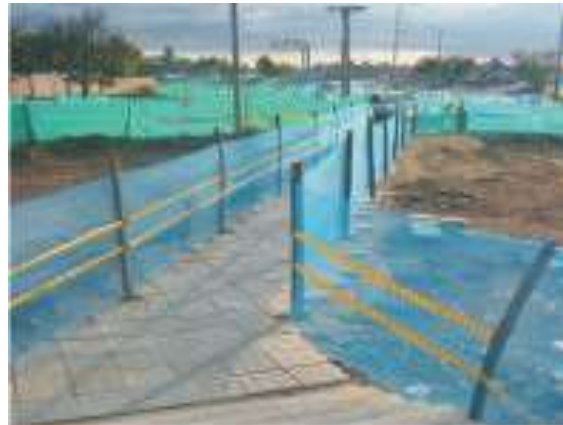
Figura N°49: Sendero para tránsito de peatones debidamente señalizados
