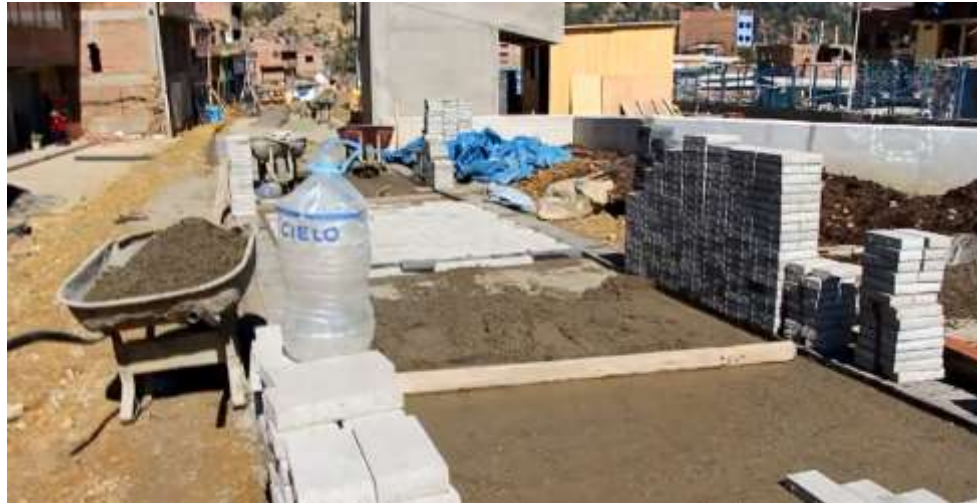
Foto N°12: Colocado de adoquines (superior e inferior)
