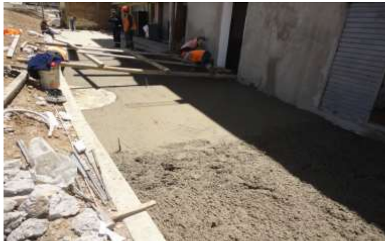
Foto N°10: Vaciado de concreto para pavimento entre Jr. San Cristóbal y el Jr. Hualcán
