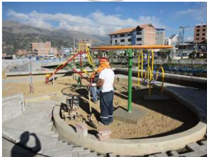
Foto N°16: Área de gimnasia.
