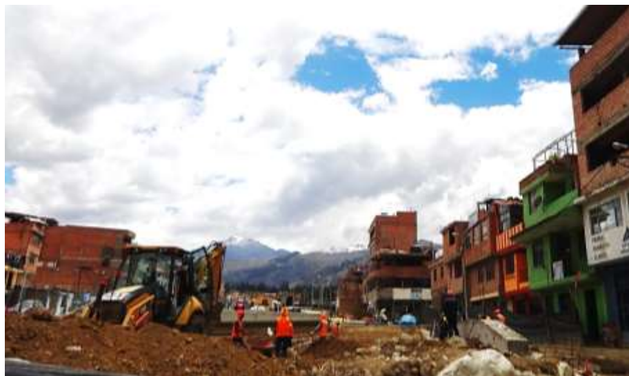
Figura N°30: Maquinaria realizando trabajos de excavación
