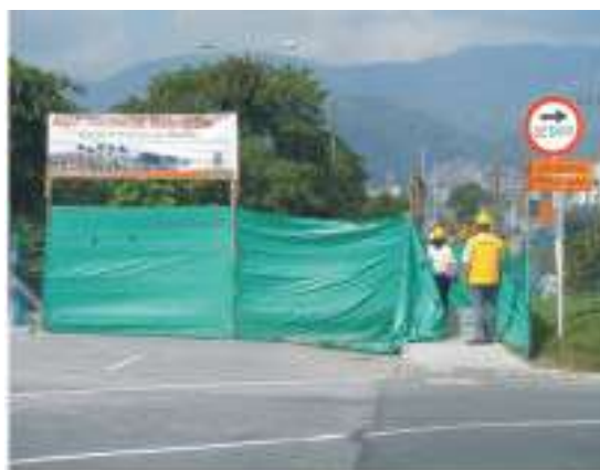
Figura N°45: Área de trabajo debidamente señalizada
