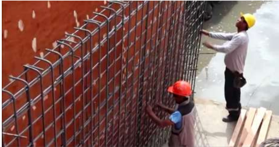
Foto N°06: Encofrado de muros de muros de contención
