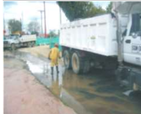
Figura N°54: Implementación de sistema de lavado de llantas
