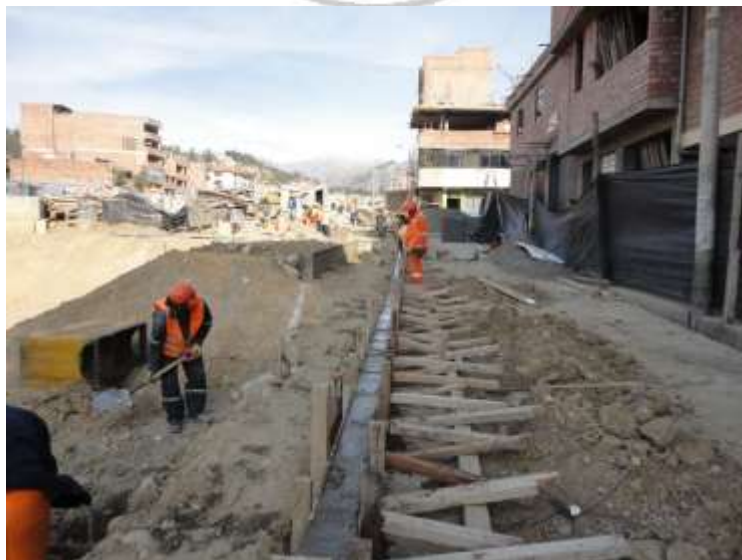
Foto N°08: Vaciado de concreto para sardinel
