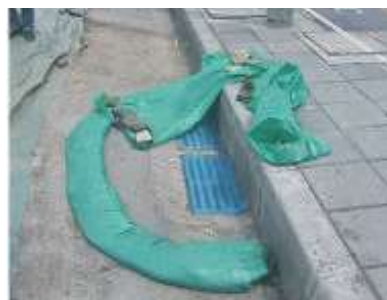
Figura N°51: Alcantarilla protegida con geotextil.
