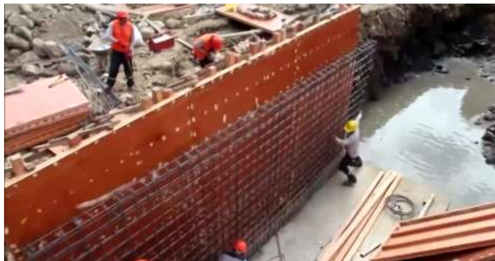
Foto N°05: Culminación del enmallado e inicio de trabajos de encofrado
