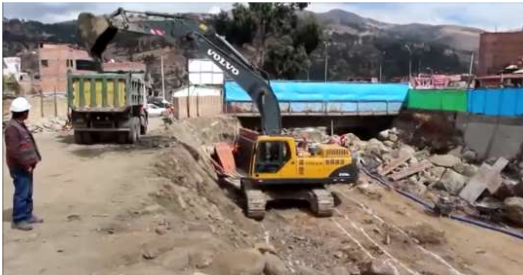
Foto N°02: Proceso de excavación y carguío con maquinarias (superior e inferior)
