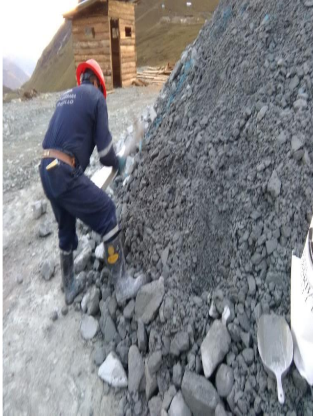
Imagen 18. Excavacion de Pozos
