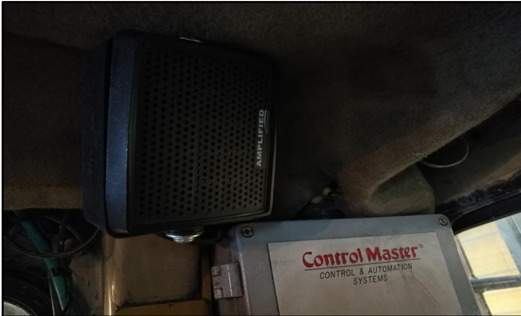
Foto 2: Speaker Instalado en la Cabina de en un Camión Minero.
