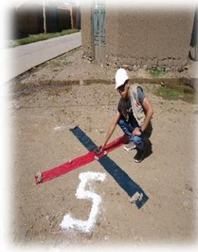
Fotografía 10: Marca del punto de control N° 5 para la fotografía con dron.
