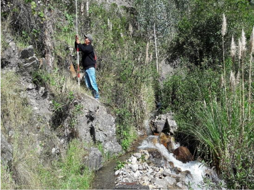
FOTOGRAFÍA N°3: Se aprecia la captación y levantamiento topografico .
