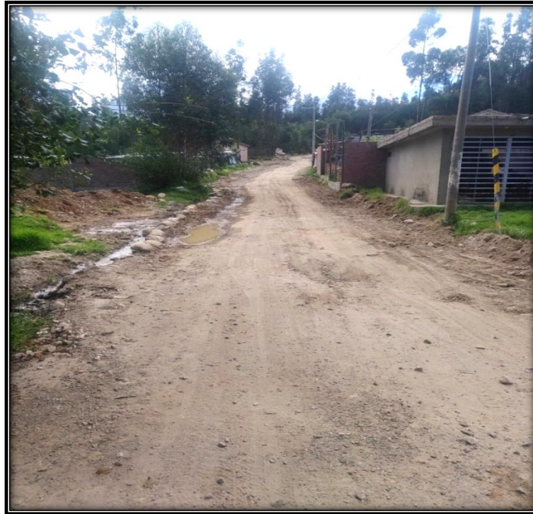
Fotografía 11 y 12: Sección por donde pasa la línea de conducción del desarenador a la planta de tratamiento.
