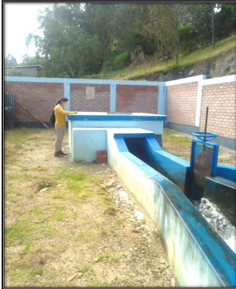
Fotografía 07: con Obras de protección en buen estado
