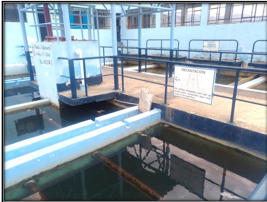
Fotografía 16: Construida hace más de 40 años.
