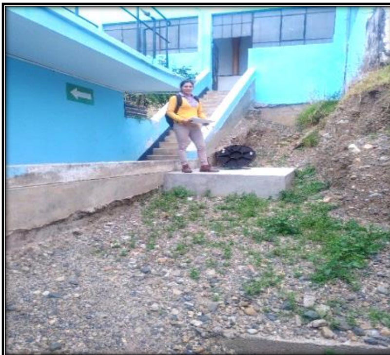
Fotografía 30: Se observa que esta sobre grava, sin presencia de napa freática
