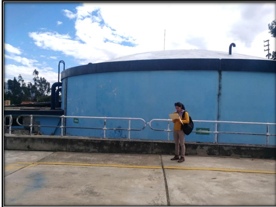
Fotografía 34: Se encuentra en buenas condiciones ( V=1800 \text{ m}^3 )
