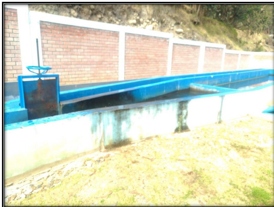
Fotografía 06: presenta condiciones regulares, pero con necesidad de mantenimiento preventivo
