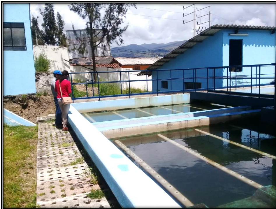
Fotografía 27: no se evidenciaron rajaduras, solo desgaste de las cámaras
