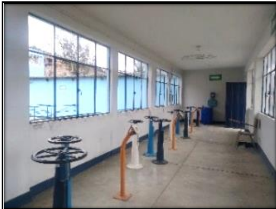
Fotografía 29: Condiciones en estado regular.
