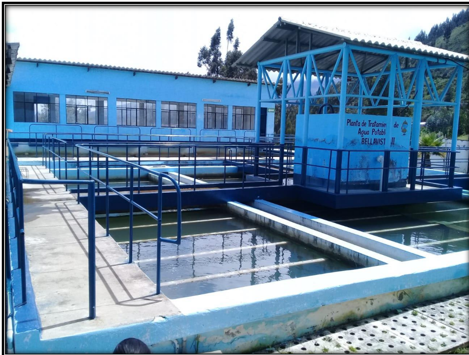
Fotografía 26: Construida en el año 1994, condiciones regulares
