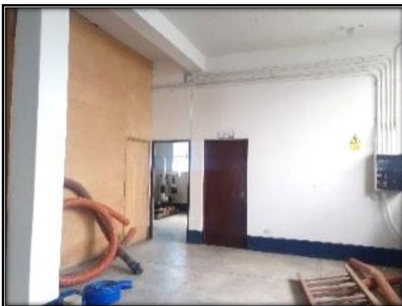
Fotografía 31: Se observa ambientes en buenas condiciones
