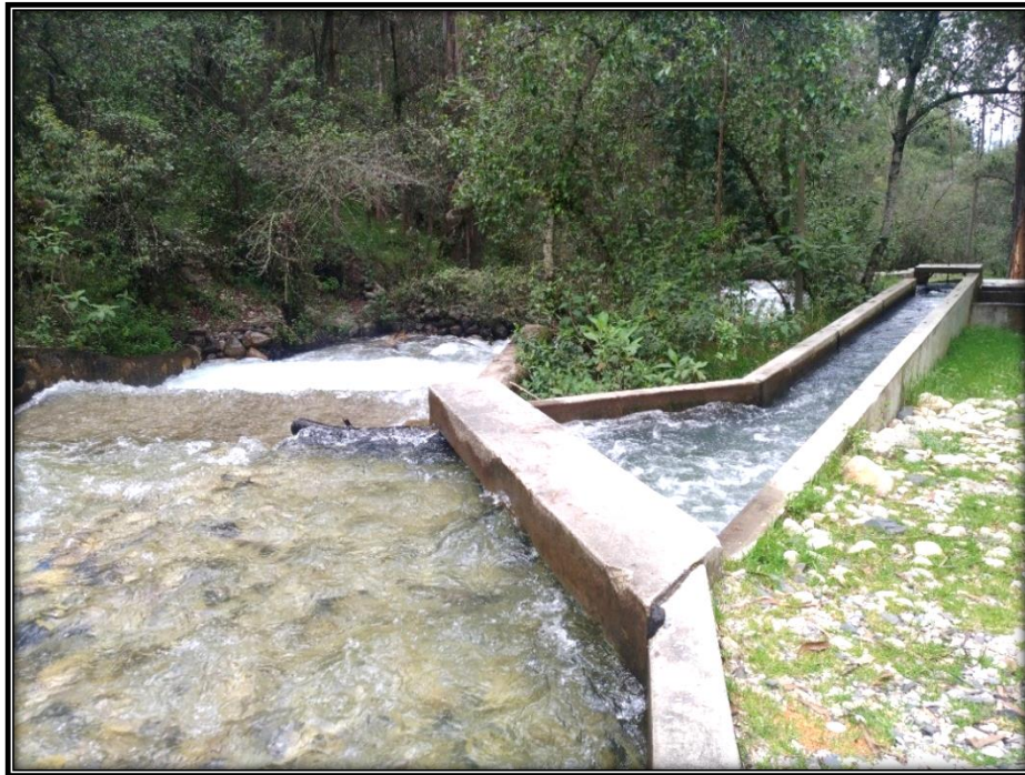
Fotografía 01: Captación Yarush de concreto armado, para captar 120 lt/s
