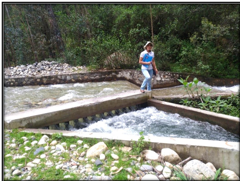
Fotografía 02: Cuenta con un muro de encausamiento de 15.00 m de largo por 0.50 m de espesor
