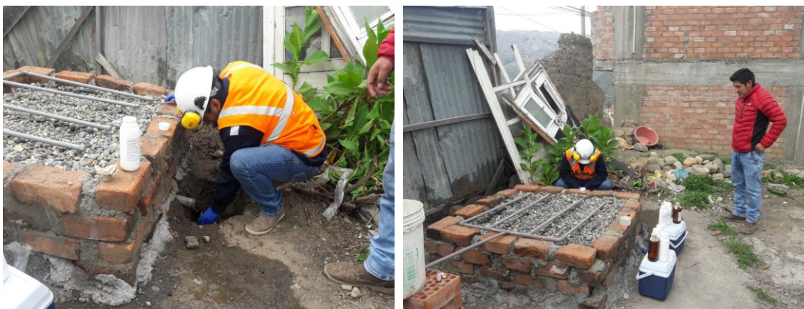
Fotografía N° 4: Toma de Muestra del Efluente del Filtro de Grava
