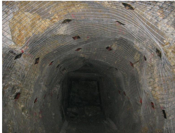
Figura 7 Sostenimiento con perno.
