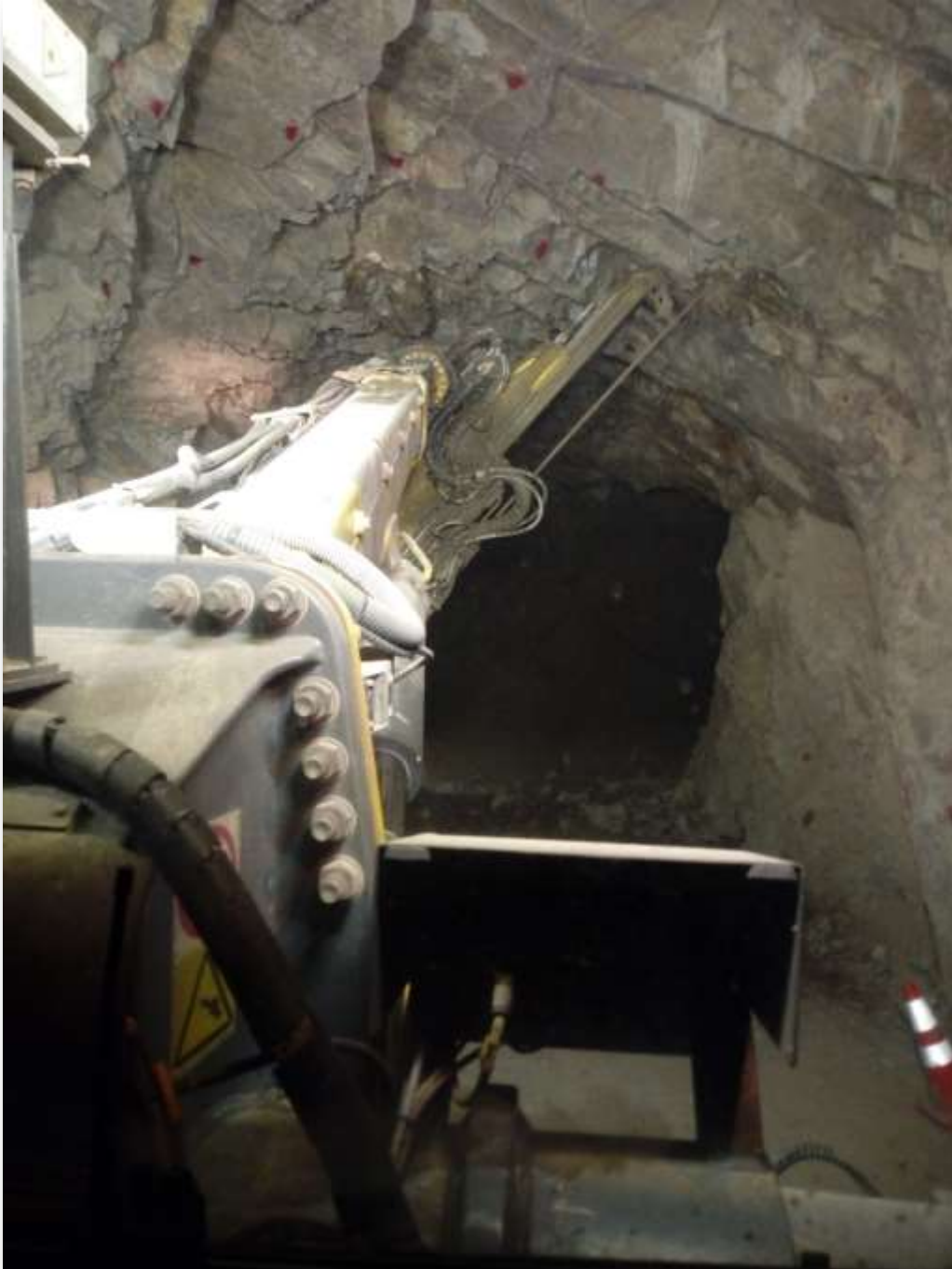
Figura 1: Jumbo realizando las perforaciones para la disposición de pernos posterior al marcado con spray rojo.
