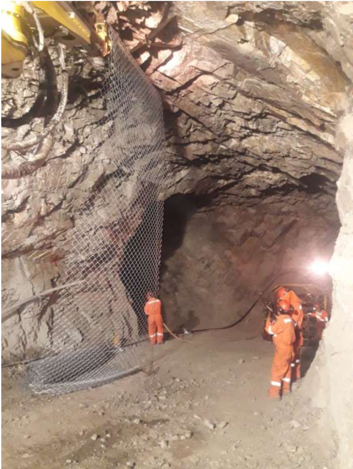
Figura 3: Instalación de la malla, con apoyo del jumbo y un cargador frontal. Fuente: El Tesista.
