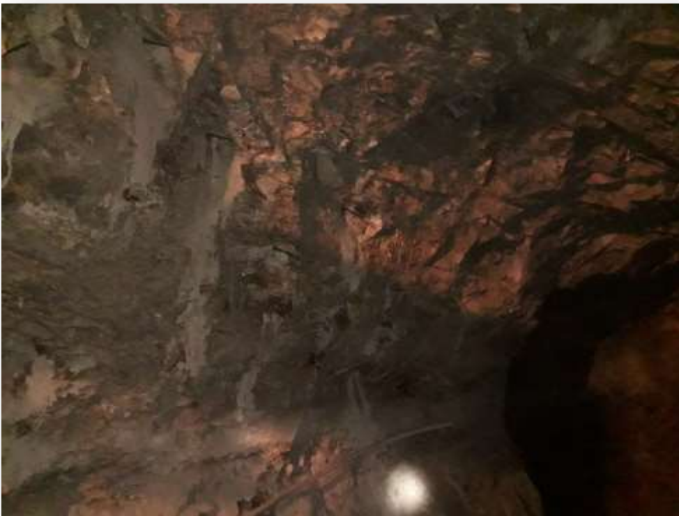
Figura 2: Acuñaadura del sector percutido e instalación de pernos. Fuente: El Tesista.
