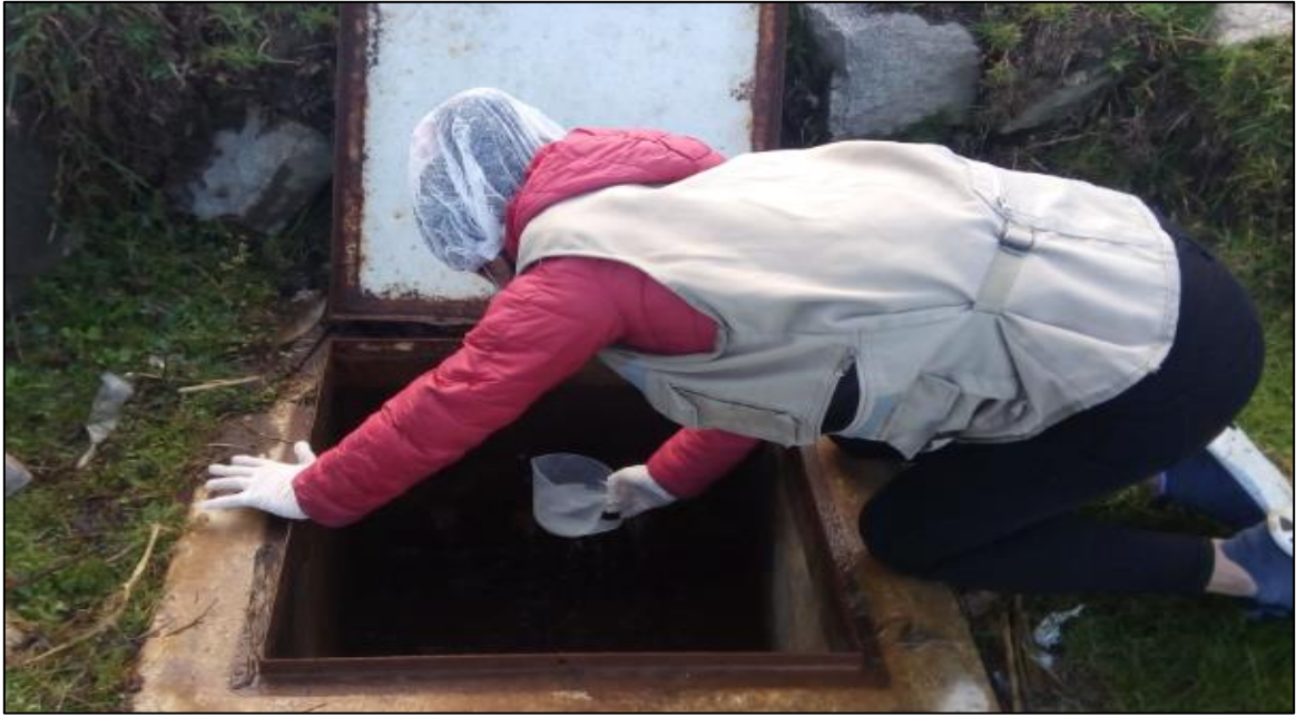
Foto N° 09: Ejecución del procedimiento general en la captación
