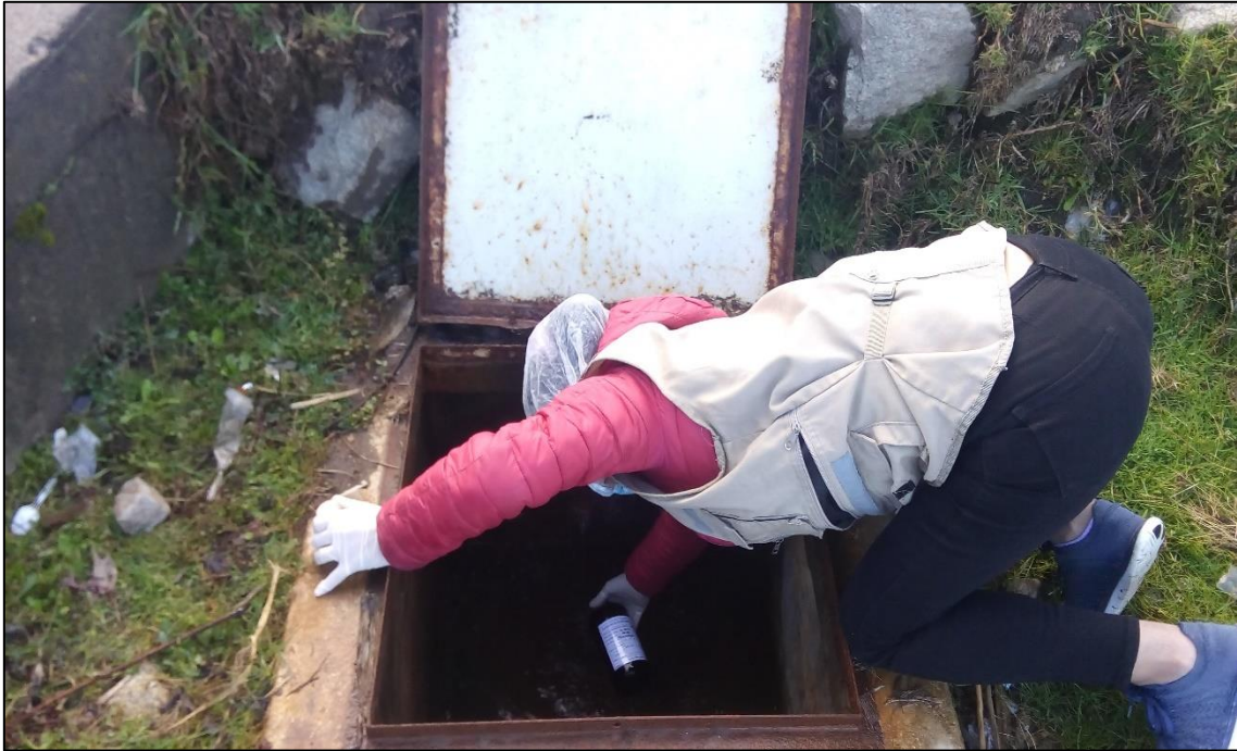
Foto N° 11: Toma de muestras en la Captación
