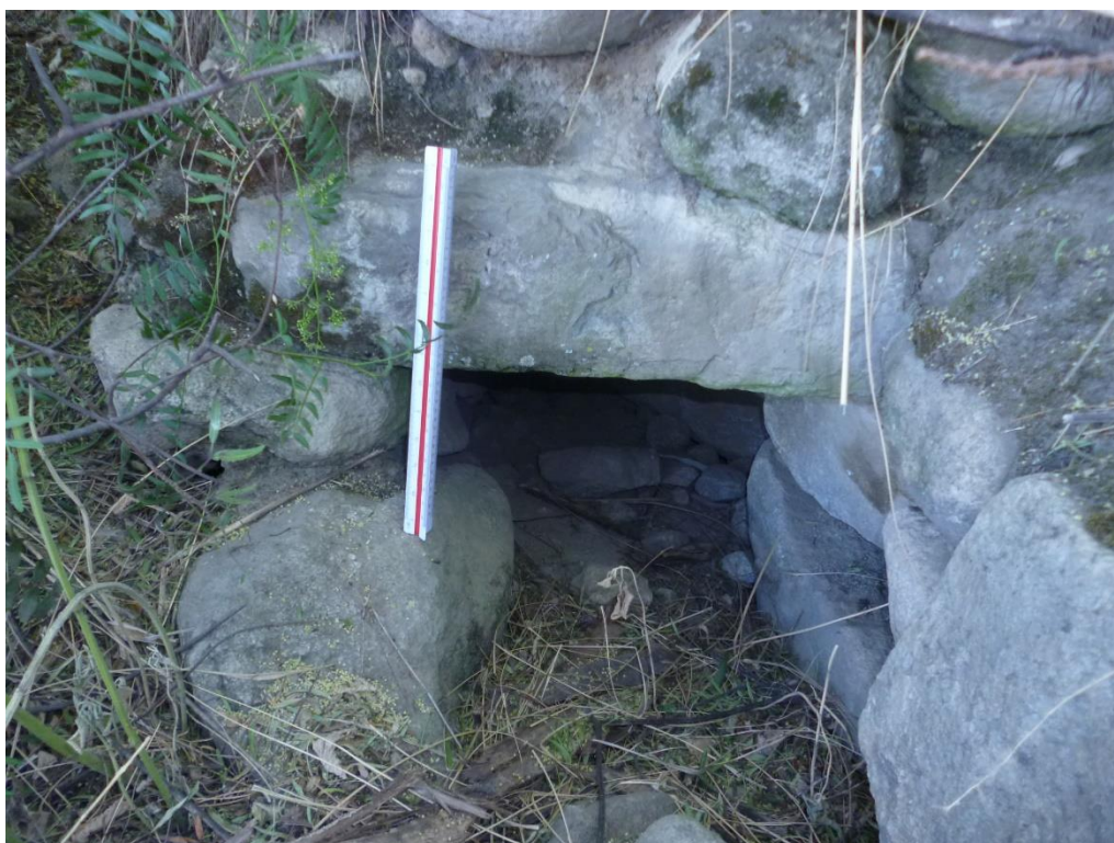
Figura 40. Ducto de ventilación con posible galería en el Sector B del sitio arqueológico Uchucoto. Foto: Toshihiro Barreto, 2021.
