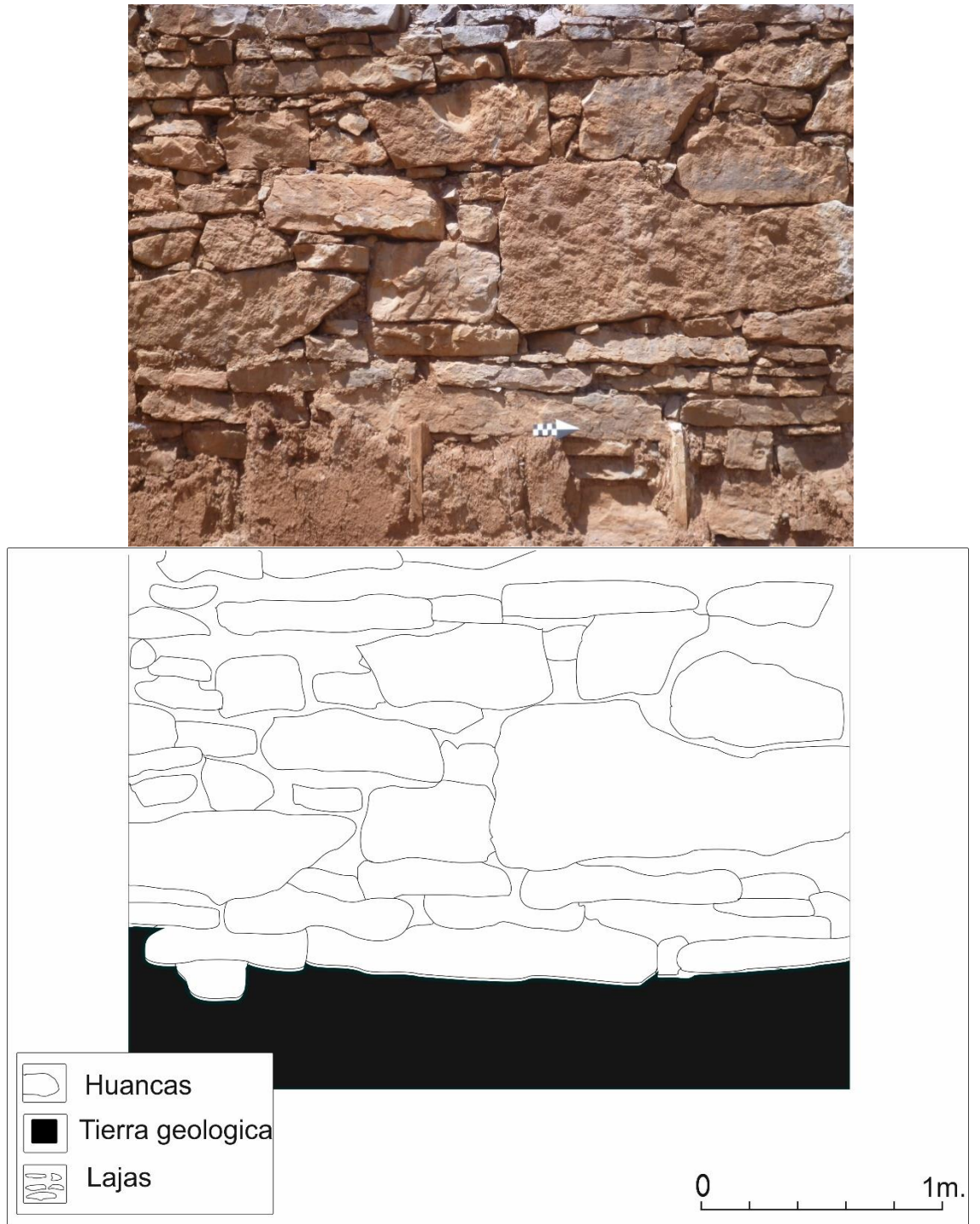
Figura 09. Muro posiblemente colonial en el Sector B del sitio Iglesia. Foto y dibujo: Toshihiro Barreto, 2021.
