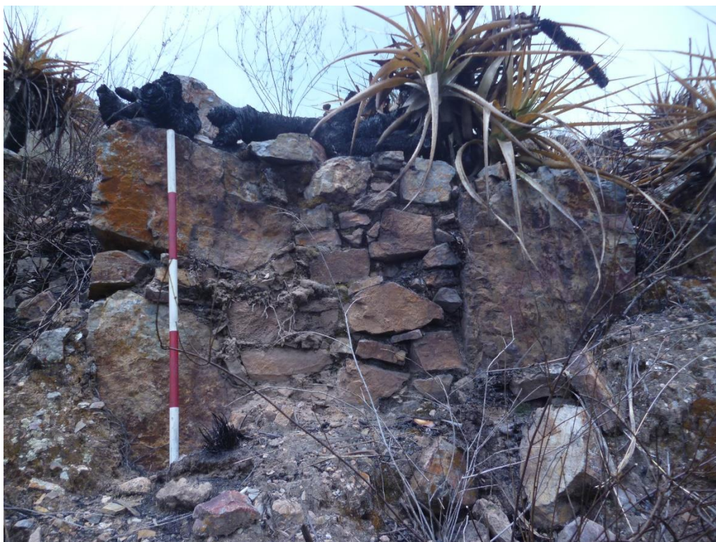
Figura 63. Muro perteneciente a un espacio residencial en la plataforma I del sitio arqueológico Pan de azúcar. Foto por: Toshihiro Barreto, 2021.
