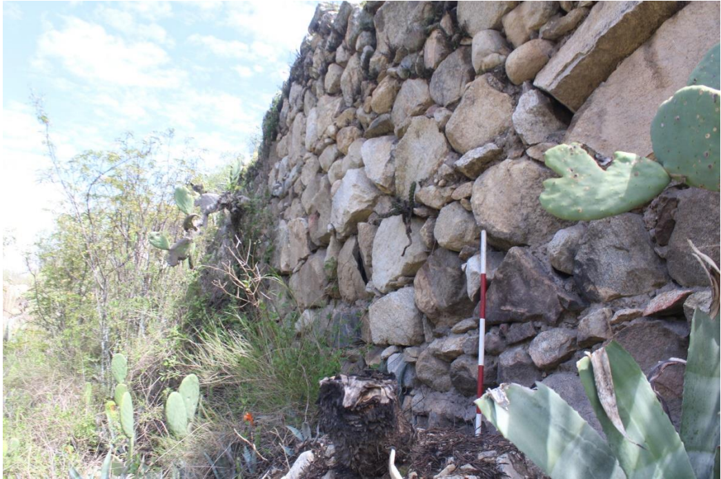
Figura 47. Muro de contención moderno del cementerio de Yungay “ Campo Santo ” en el sitio arqueológico Huantsakay. Foto: Toshihiro Barreto, 2021.
