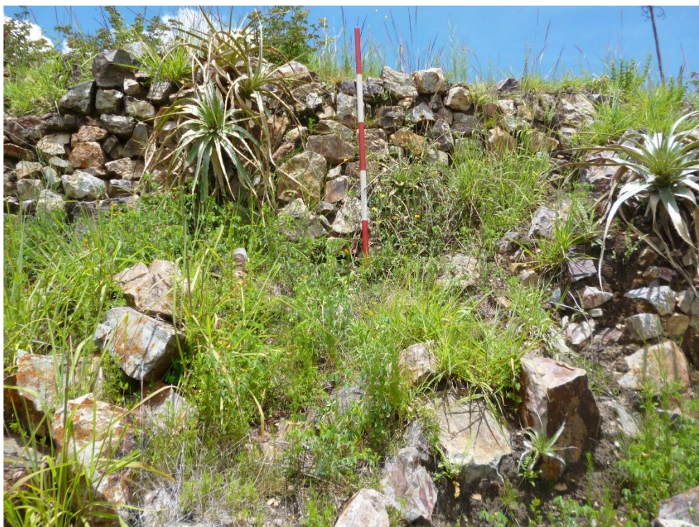
Figura 18. Muro de contención del Sector B en el sitio arqueológico Llusho. Foto: Toshihiro Barreto, 2021.
