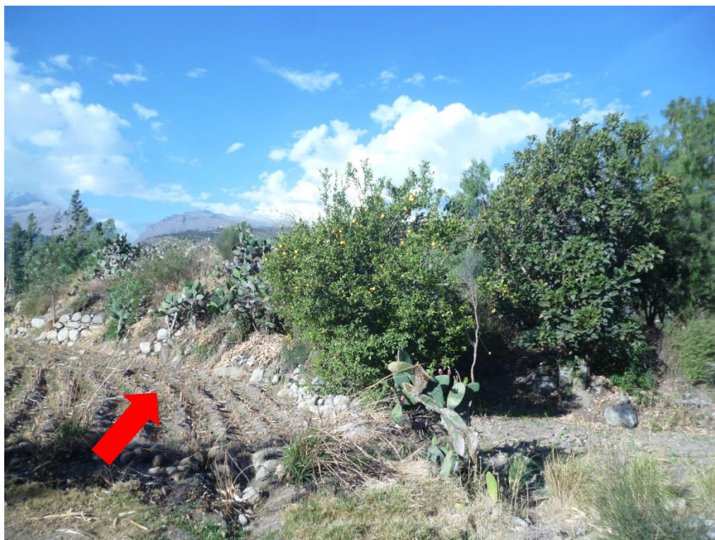
Figura 37. Vista del muro perimetral circular destruida por la invasión agrícola en el Sector A del sitio Uchucoto. Foto: Toshihiro Barreto, 2021.
