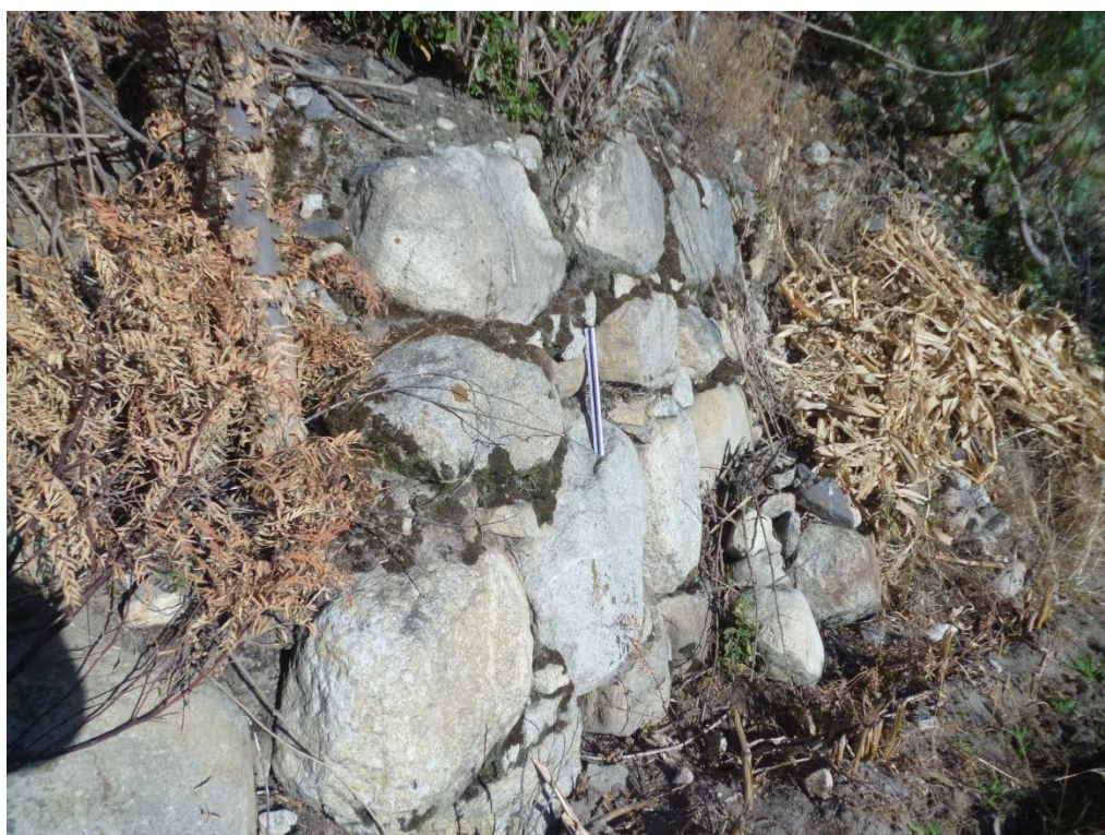
Figura 38. Una parte del muro circular en detalle del Sector A en el sitio arqueológico Uchucoto. Foto: Toshihiro Barreto, 2021.
