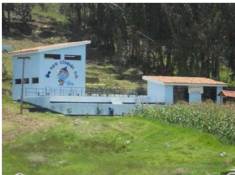
Vista de la Planta de Tratamiento - 2012
