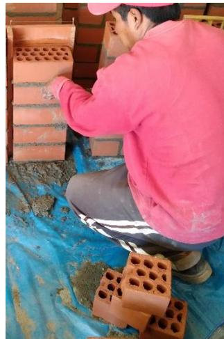
**Figura 4.6.** Asentado de Pilas.
