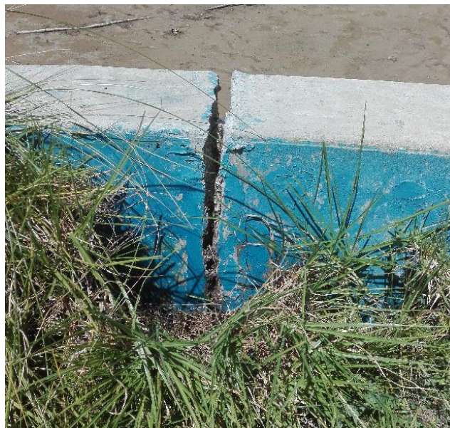
Figura 3. Vista de una Junta de Dilatacion, la Abertura en la Union entre Muros es en Forma de “V”
