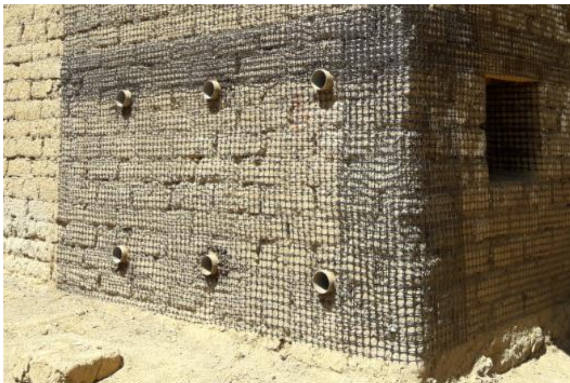
Figura 10. Detalle de colocación de tubos inferiores y superiores y enmallado realizado mediante geomalla.
