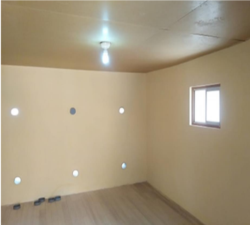
Figura 20. Culminación del sistema de aislamiento en cielo raso con MDF, doble ventana, piso de machihembrado, tubos de pared caliente con sus respectivos tapones e instalación eléctrica.
