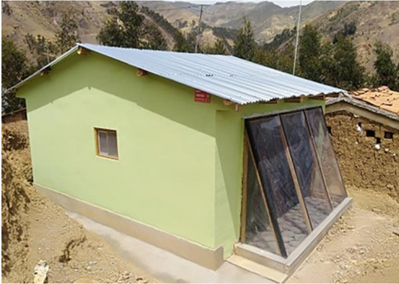
Figura 22. Vivienda con acondicionamiento térmico, acabado.
