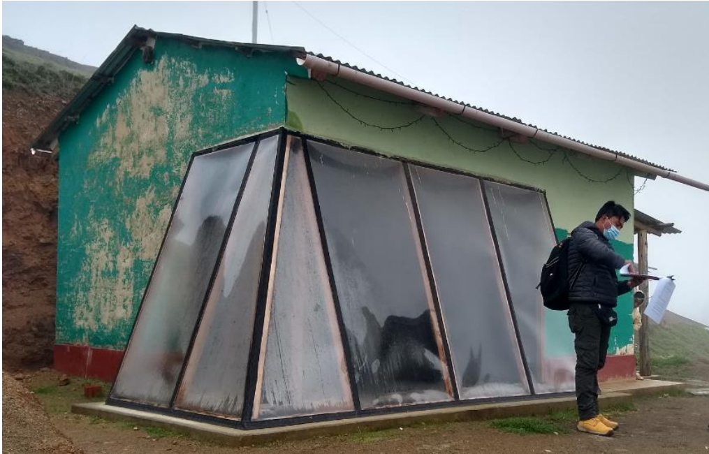
Figura 6. Vivienda con acondicionamiento térmico en el centro poblado de Pia Corral, donde se puede observar el muro trombe.
