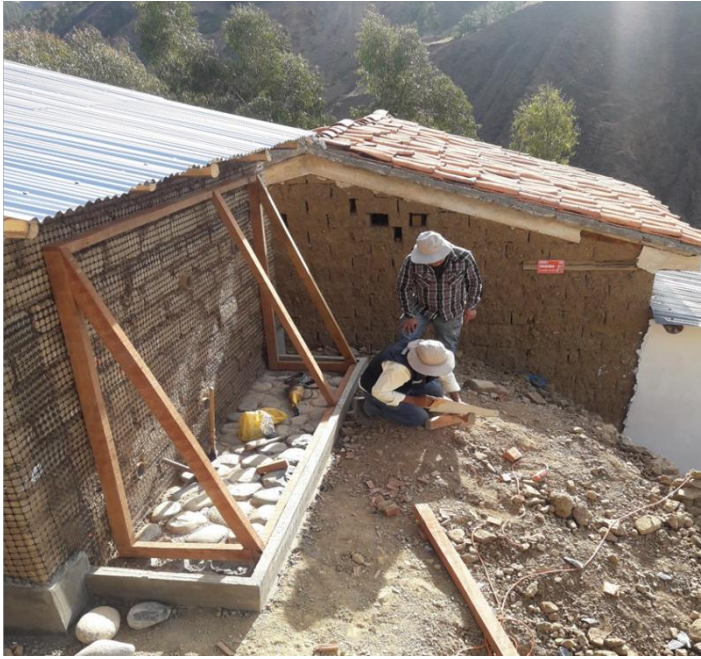
Figura 14. Instalación de 6 tubos de diámetro de 4"x0.50cm, vereda de muro trombe con concreto ciclópeo y estructura del muro trombe.
