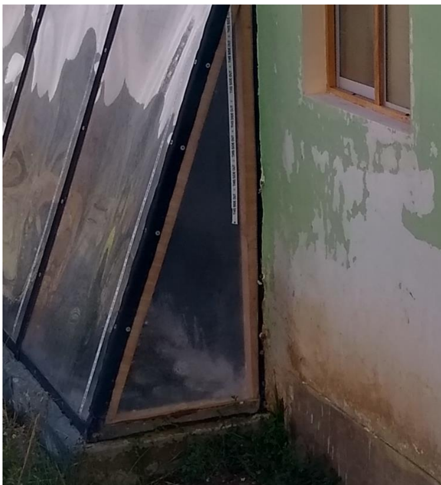
Figura 8. Detalle de emboquillado de piedras redondeadas en el centro poblado de Ocsha Pachan
