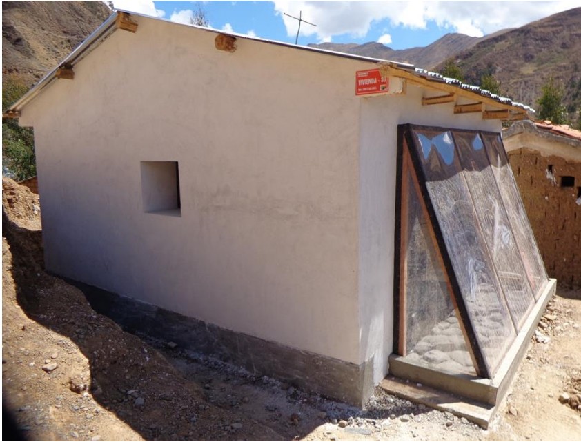
Figura 16. Contrazócalo cemento sin pintar H=0.40m y culminación de pared caliente de dormitorio.
