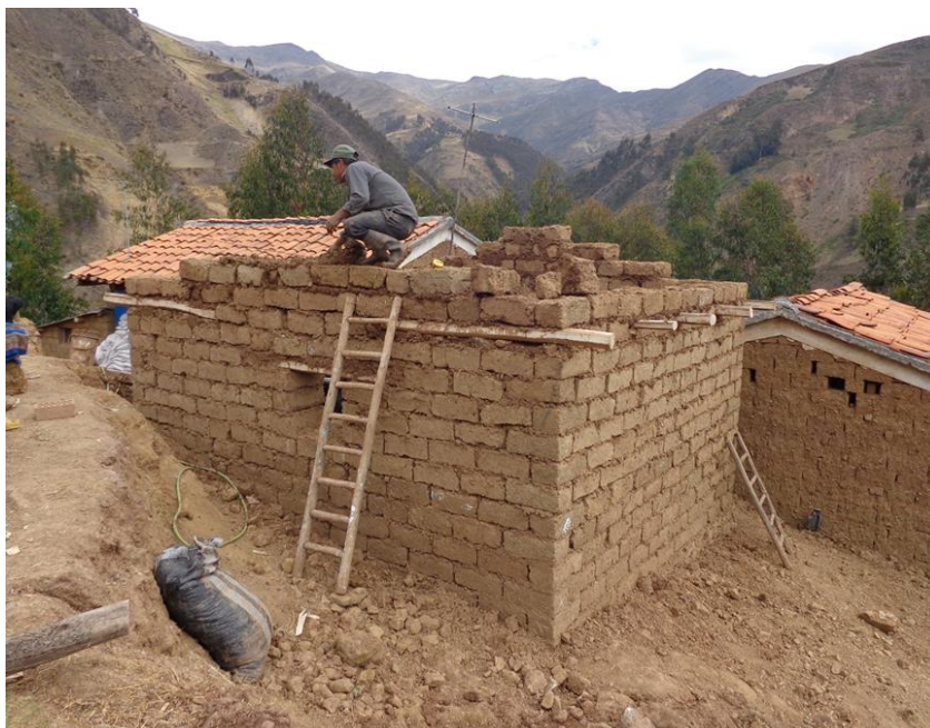
Figura 12. Vivienda en proceso de construcción antes de ser intervenida
