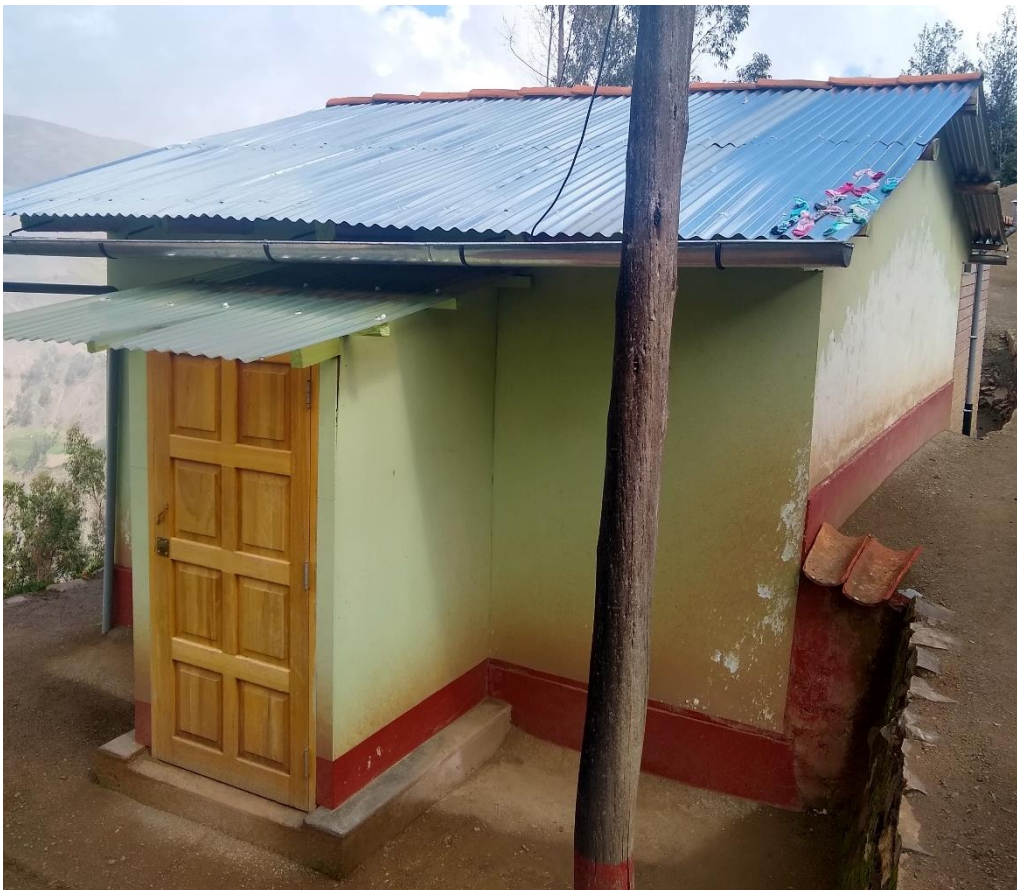
Figura 9. Sistema de doble puerta, en el centro poblado de Ocsha Pachan.
