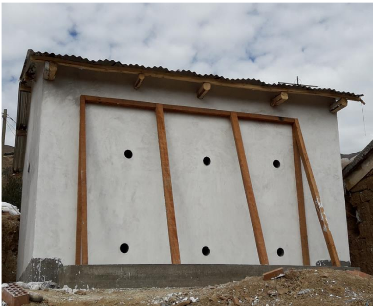
Figura 15. Terrajeo interior y exterior con yeso.
