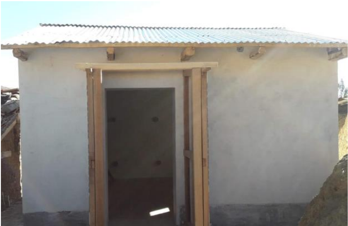
Figura 11. Detalle de sistema de doble puerta, vivienda del centro poblado Pía Corral.
