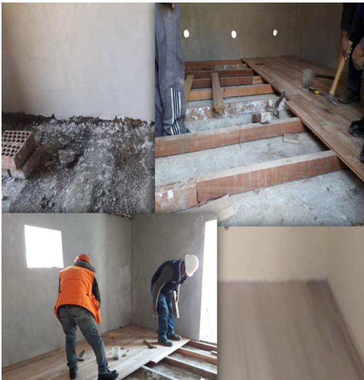
Figura 17. Adecuación de dados para que soporten las durmientes del machimbrado y Piso de Machimbrado madera tornillo siml \frac{3}{4} ".
