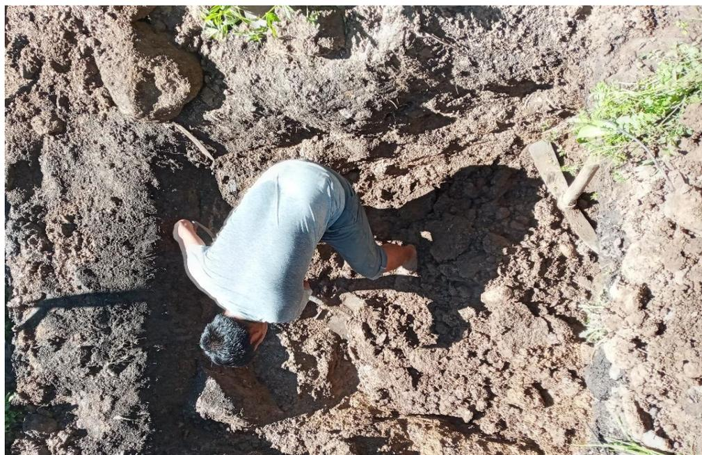
*Figura 7.* Excavación de terreno para la instalación de lisímetro de drenaje.
