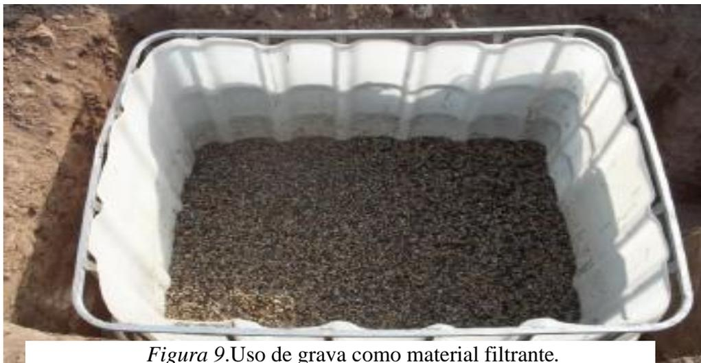
*Figura 9.* Uso de grava como material filtrante.
