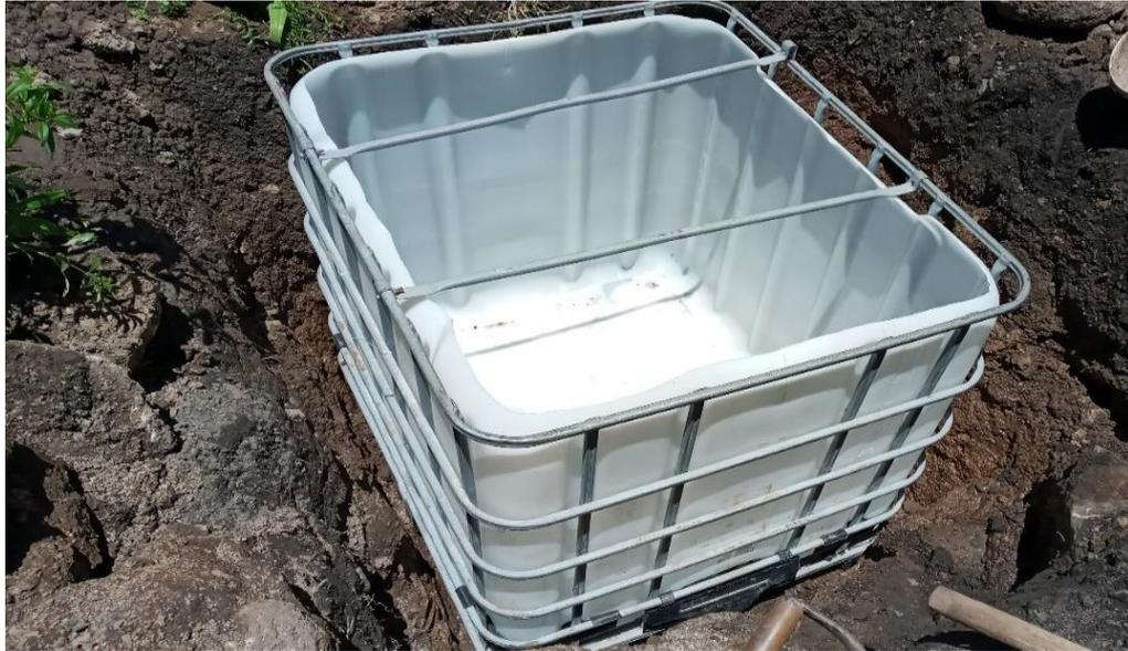
*Figura 8.* Tanque utilizado para la construcción del lisímetro de drenaje
