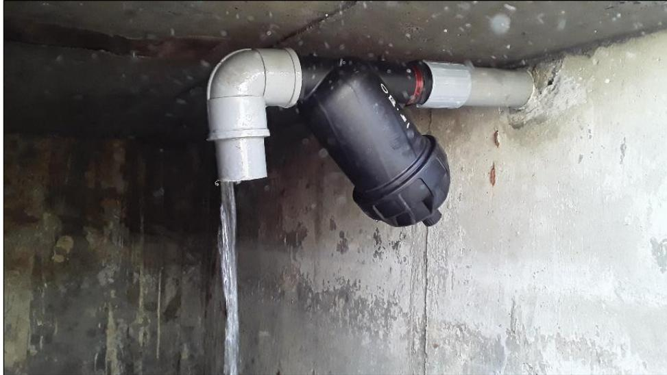
Lavado del tanque y limpieza del filtro de anillas
