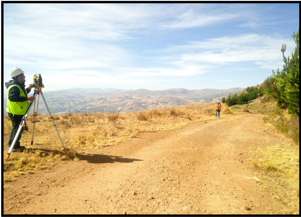
Fotografía 01: Levantamiento topográfico de carretera.
