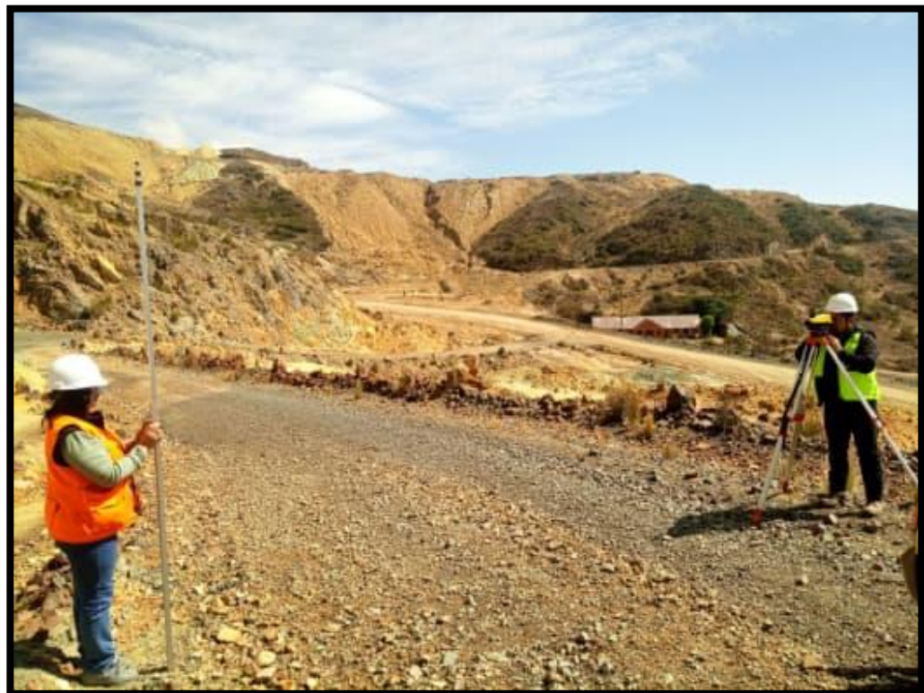
Fotografía 04: Levantamiento de niveles para cálculo de peraltes.
