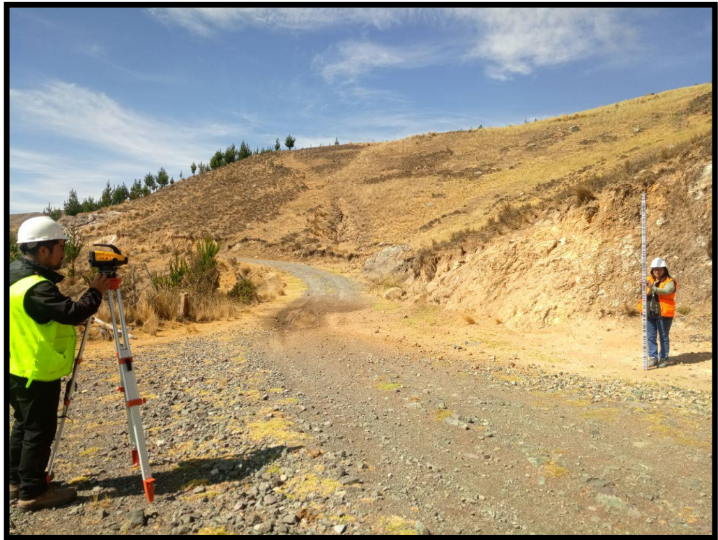
Fotografía 03: Levantamiento de niveles para cálculo de peraltes.
