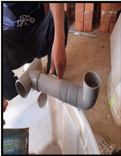
FOTOGRAFÍA 09: Instalación del sedimentador auxiliar
