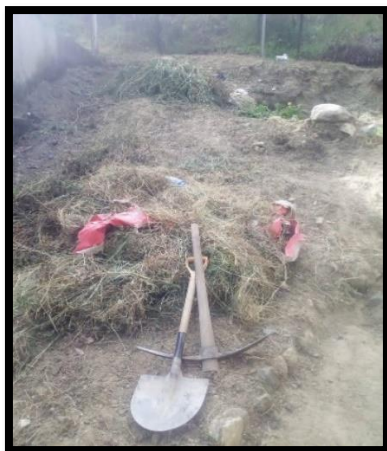
FOTOGRAFÍA 13: Limpieza del terreno a escarbar para instalación de tuberías
