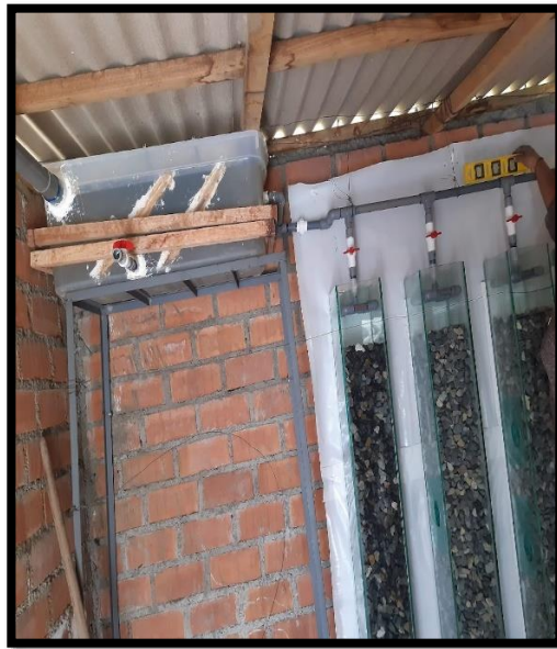
FOTOGRAFÍA 10: Colocación del sedimentador sobre el soporte metálico
