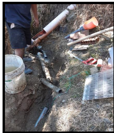
FOTOGRAFÍA 14: Instalación de la tubería para la captación del afluente
