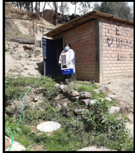
FOTOGRAFÍA 31: Caseta donde se encuentra ubicado el sistema de tratamiento del agua residual
