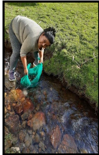
FOTOGRAFÍA 05: Lavado de la grava para eliminar impurezas y malezas existente
