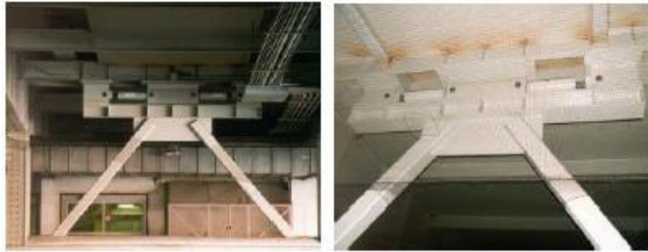
Ilustración 19: Refuerzo Adicional que se usa en la Disposición Chevron
