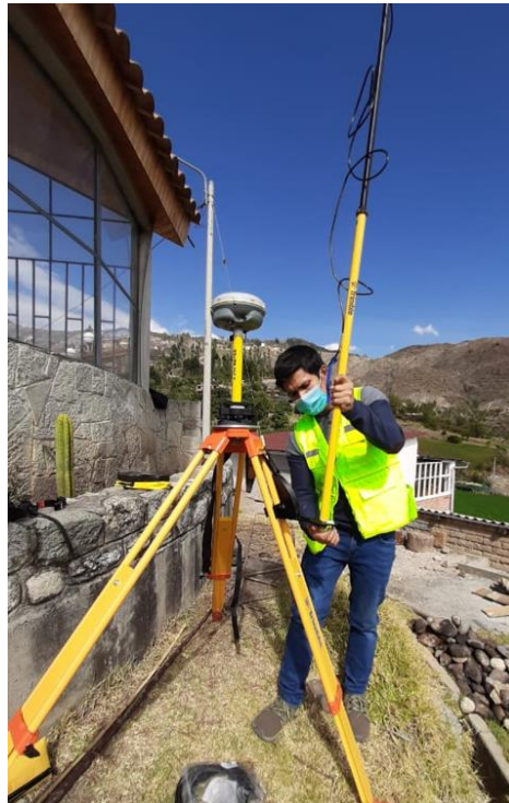
Figura 80: Colocación de la antena del gps diferencial.
