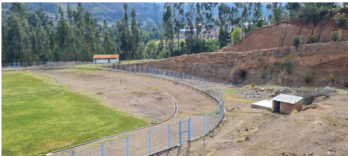
Figura 6: Reconocimiento de estructuras existentes en el área de estudio.
