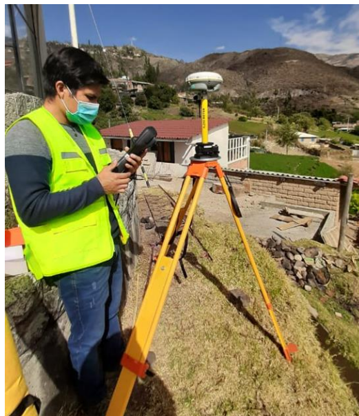
Figura 77: Trípode y base gnss estacionadas.
