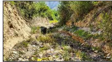
Cauce aguas arriba del puente
