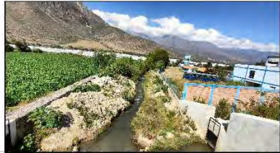
Cauce aguas abajo del puente
