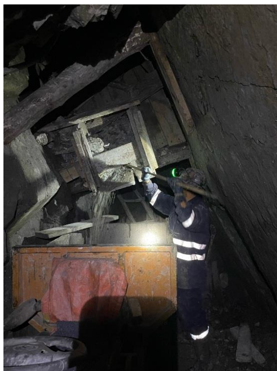
Fotografía 5. Proceso de Carguío (chuteo) en el nivel 2.
