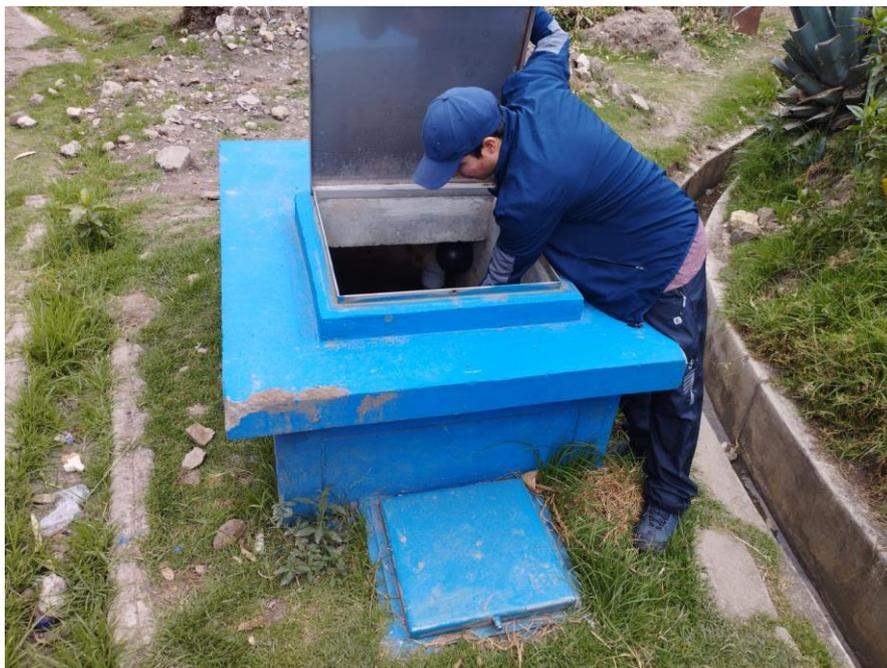
**Fotografía 8.** Medición de cloro residual libre en los reservorios de la microcuenca Caras, para determinar la calidad del agua potable.
