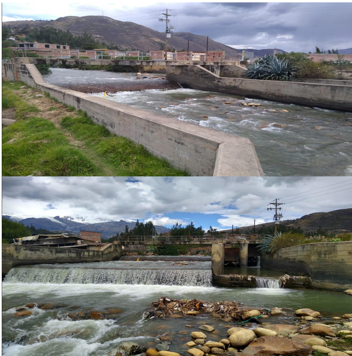
Figura 1 Bocatoma Allpa Rumi existente en el río Marcará.
