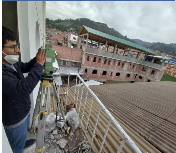
Fotografía N°04 Levantamiento Topográfico a la cobertura de la Iglesia.
