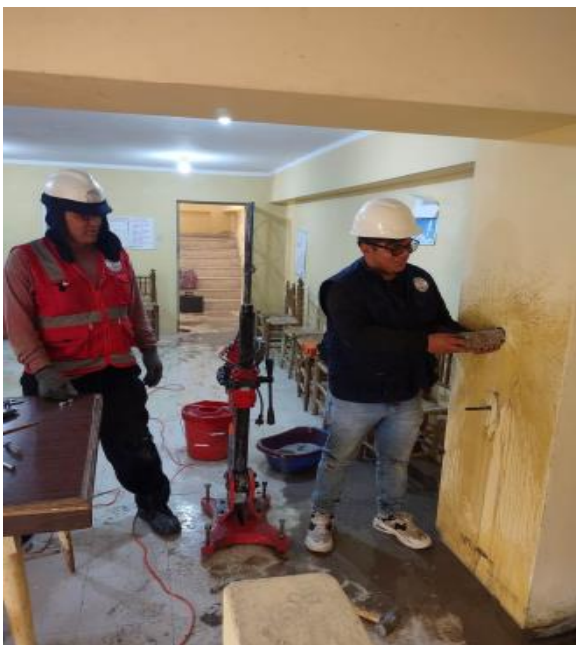
Fotografía N°15 Extracción de núcleo de concreto en las columnas.
