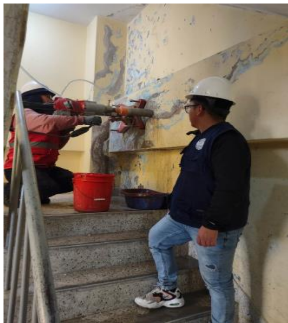
Fotografía N°16 Extracción de núcleo de concreto en las vigas.
