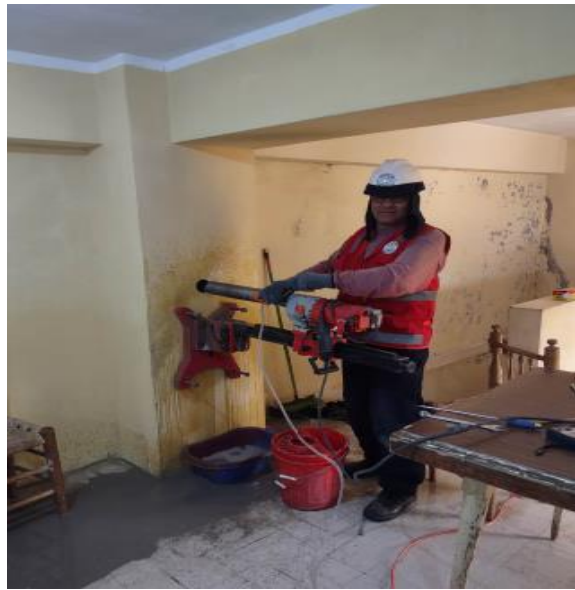
Fotografía N°14 Extracción de núcleo de concreto en las columnas .
