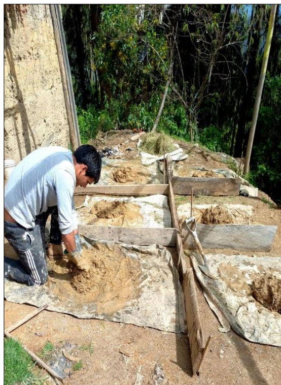
Fotografía 11 – 14. Preparación del adobe conforme a la cantidad de ceniza de hoja de eucalipto.
