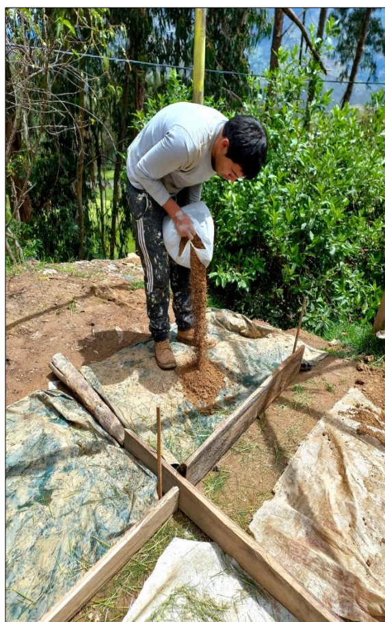
Fotografías 9 – 10. Preparación de la mezcla para el adobe.
