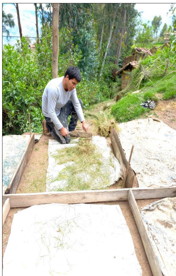
Fotografías 9 – 10. Preparación de la mezcla para el adobe.
