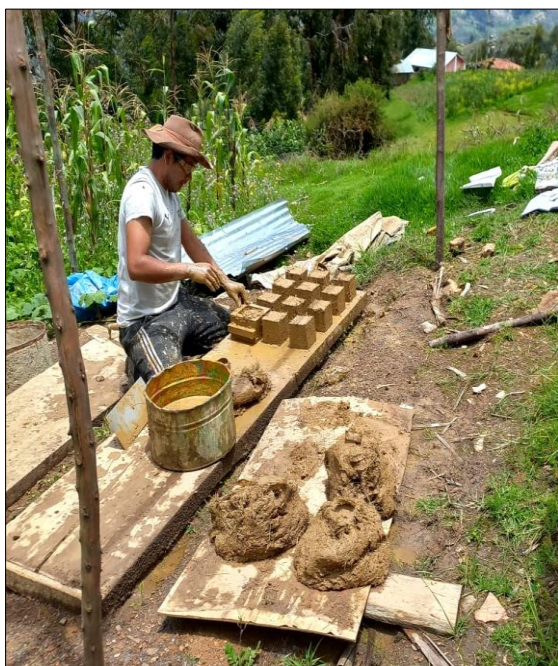
Fotografía 15 – 17. Formación de adobes y su preparación para el secado.
