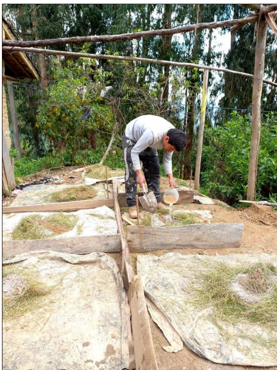
Fotografía 11 – 14. Preparación del adobe conforme a la cantidad de ceniza de hoja de eucalipto.
