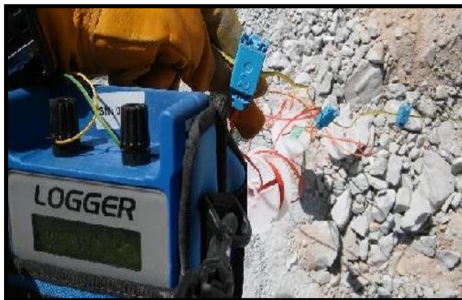
Figura N° 24. Conexión y registro de los detonadores.
