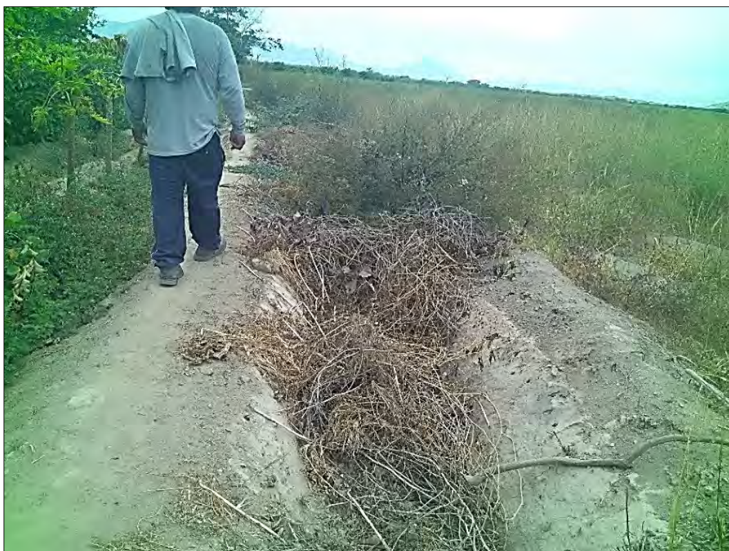
Se muestra sección canal Tabón Bajo, anteriormente canal trapezoidal revestido.
