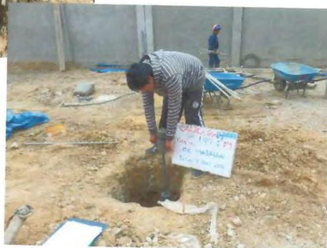
Calicata C-4. Se observa ensayo de DPL.
