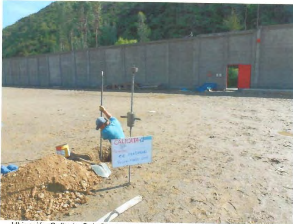
Ubicación Calicata C-1. Se observa el material extraído y ensayo de DPL.
