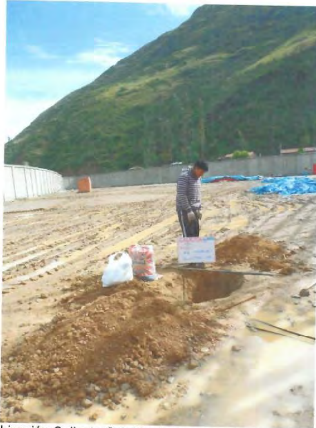
Ubicación Calicata C-3. Se observa el material extraído.
