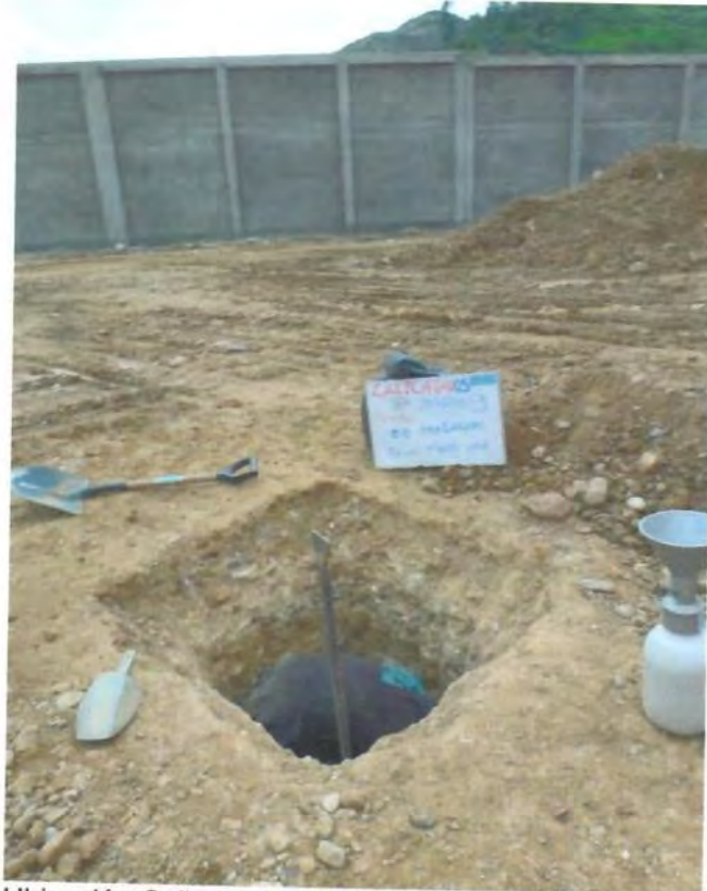
Ubicación Calicata C-5. Se observa material extraído.
