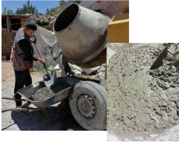
Foto 49: mezclado de concreto en ambiente habilitado.
