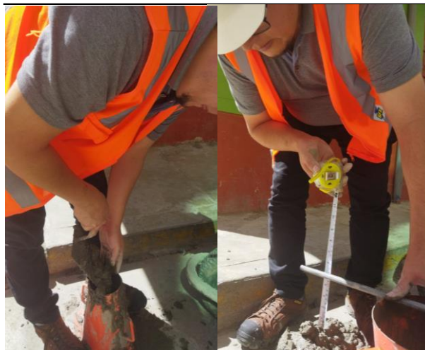
Foto 53: Verificación de asentamiento slump
