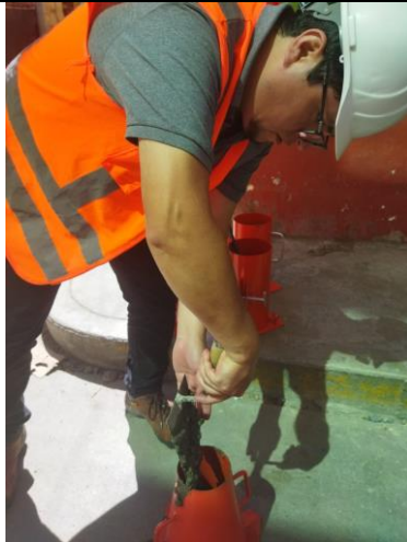
Foto 51: procedimiento de ensayo de asentamiento slump
