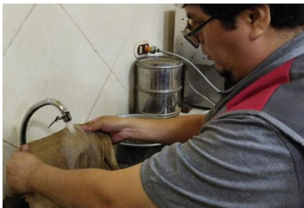
Foto 73: preparación de curado con mantas húmedas
