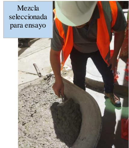
Foto 50: Mezcla apartada para ensayo de asentamiento slump.
