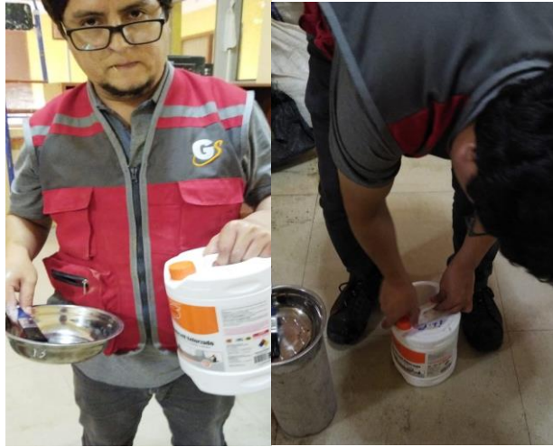
Foto 67: Preparación del aditivo curador membranal
