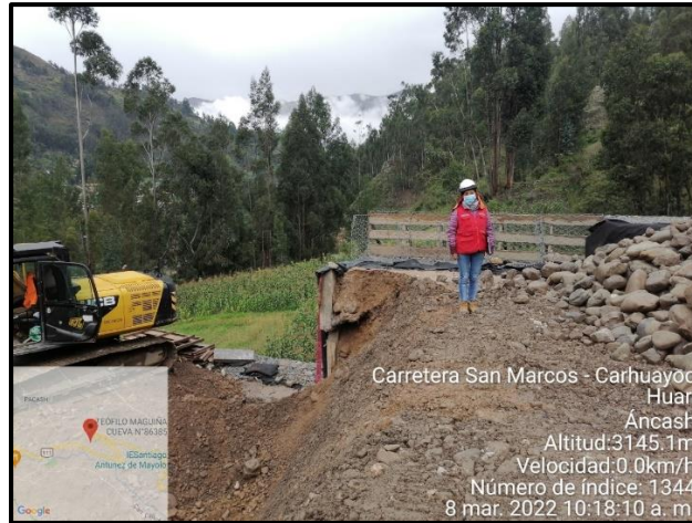
Fotografía 18: Conformación de la plataforma 3 de planta de tratamiento de aguas residuales
