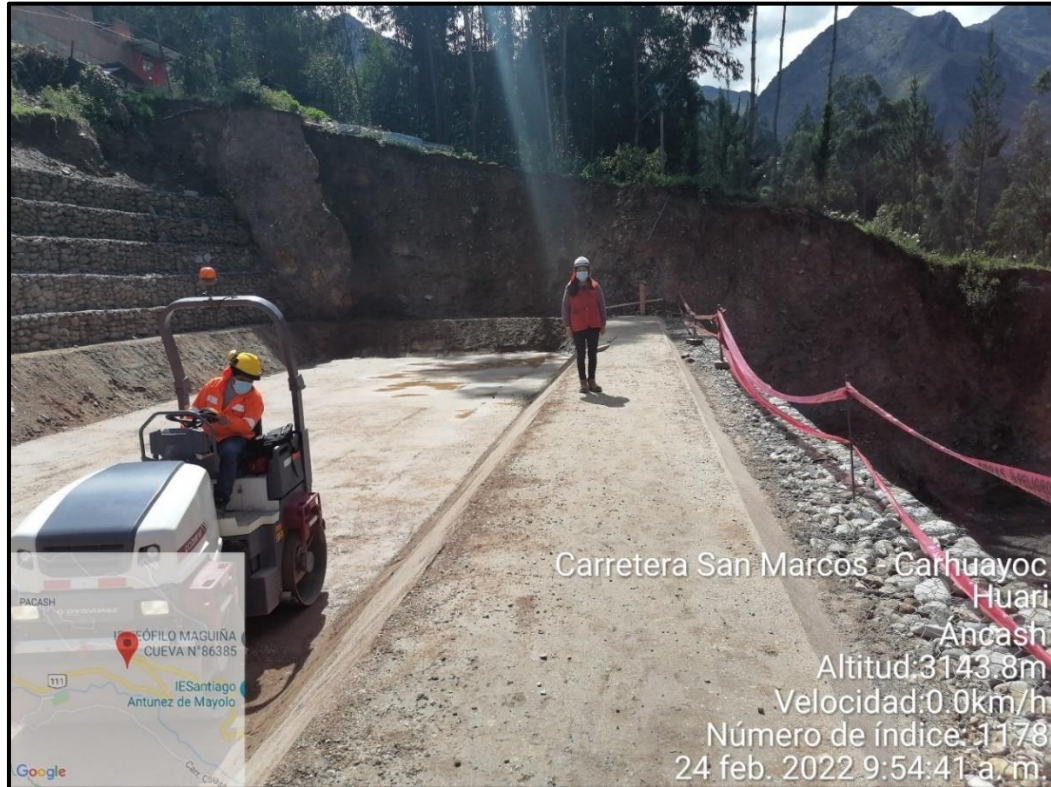
Fotografía 15: Nivelación de Humedales
