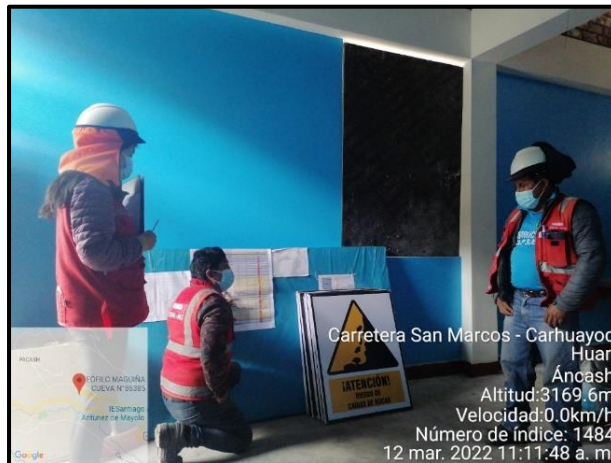
Fotografía 19: Reuniones de planificación semanal en el frente de la planta de tratamiento de aguas residuales
