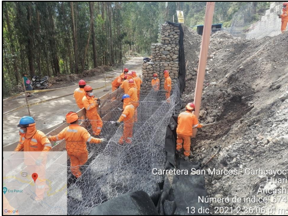
Fotografía 12: Instalación de muro de gaviones tipo caja
