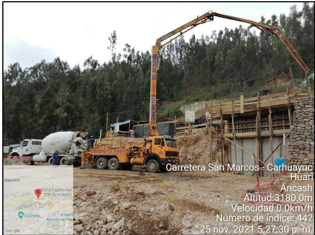
Fotografía 10: Vaciado de concreto de tanque Imhoff
