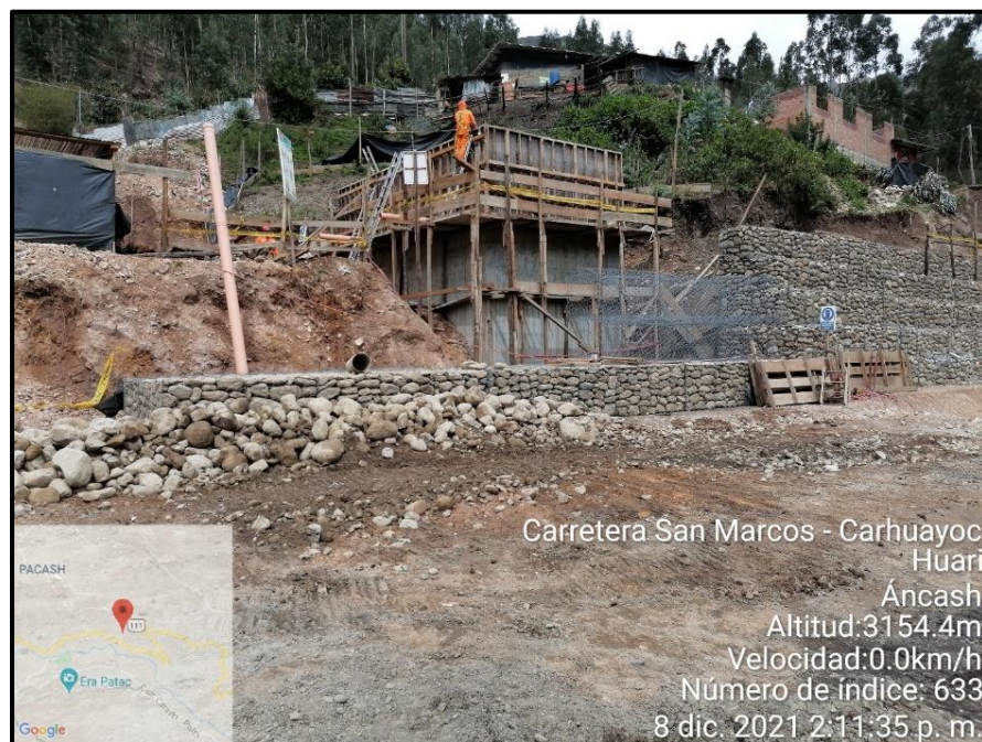
Fotografía 11: Actividades de encofrado en el Tanque Imhoff
