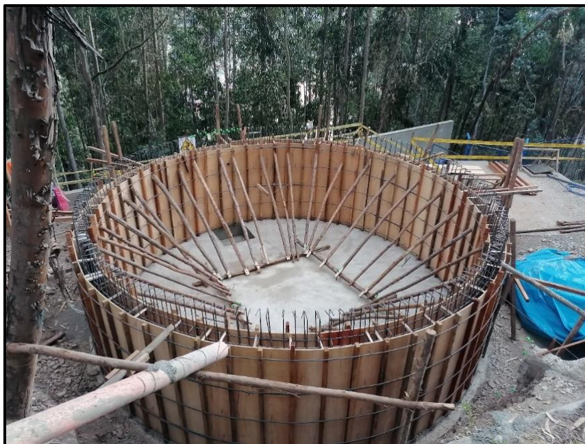
Fotografía 03: Encofrado de la pared cilíndrica del reservorio
