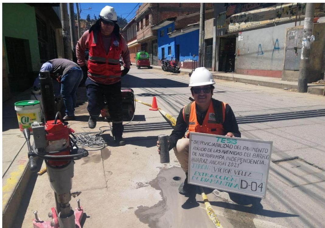
**4.1.6.8. Procedimiento de Ensayo a Compresión del Testigo Diamantino.** Tal como lo establece la NTP 339.034 del año 2015 y habiendo cumplido los siete (07) días posteriores a la extracción de los testigos diamantinos se procedió de la siguiente manera:
