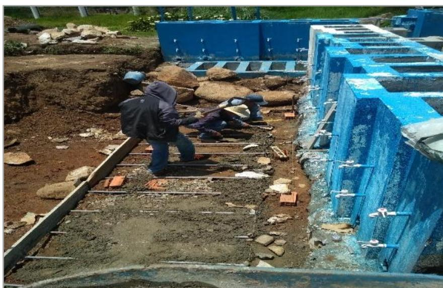
Fotografía 2. Proceso constructivo sedimentadores secundarios.
