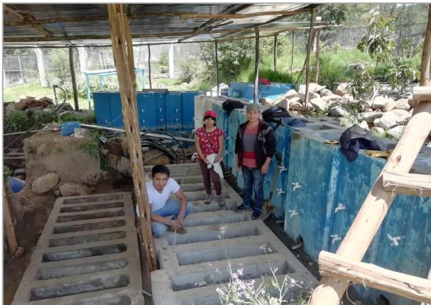
Fotografía 4. Sedimentadores listos para entrar en operación del sistema de tratamiento.
