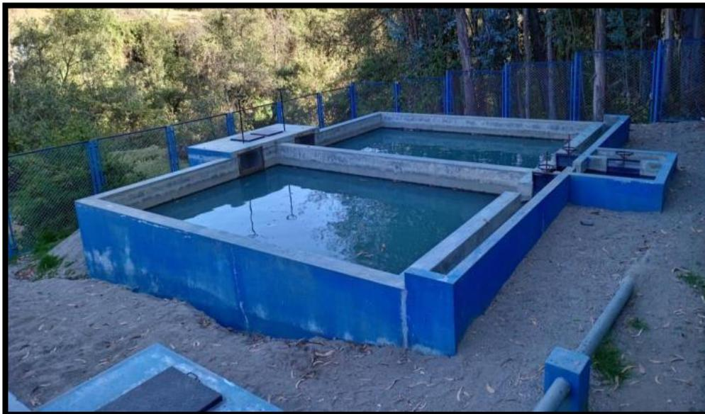
**FOTOGRAFIA N°4 SE OBSERVA LA PLANTA DE TRATAMIENTO DE AGUA POTABLE FILTROS LENTOS ESTRUCTURALMENTE BUENO, HIDRAULICAMENTE EN MAL FUNCIONAMIENTO.**
