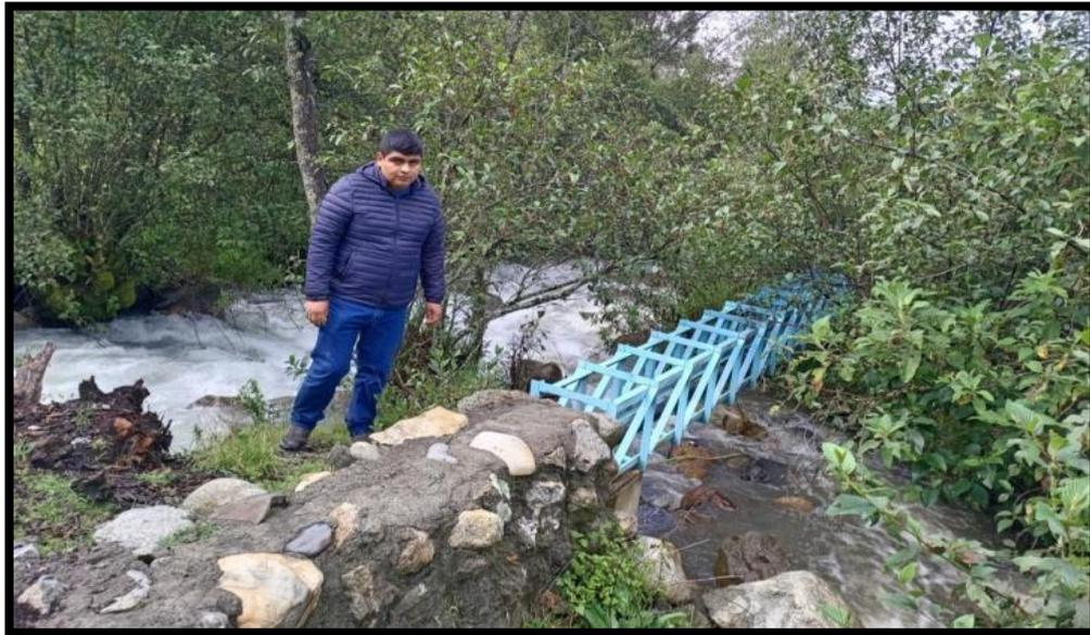
**FOTOGRAFIA N°3 SE OBSERVA LA LINEA DE CONDUCCION EN PERFECTAS CONDICIONES POR SER UNA CONSTRUCCION NUEVA, PRECISAMENTE EN UN CRUCE AEREO.**
