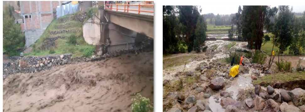
Rio Llacshahuanca-Rio seco
